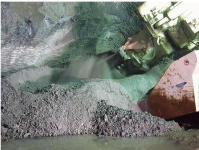
Abb. 6: Ausbruch mit der schweren Teilschnittmaschine in Quarzphylliten. Durch die geringe Zerlegung des Gebirges sind die Schneidspuren jedes Meißels an der Ortsbrust deutlich erkennbar (Foto: Plinninger).
