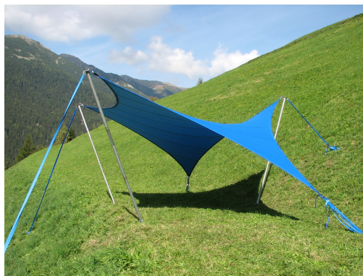
Realisierung eines 5-Punktsegels mit den am Lehrstuhl für Statik entwickelten Methoden für Formfindung und Zuschnitt
