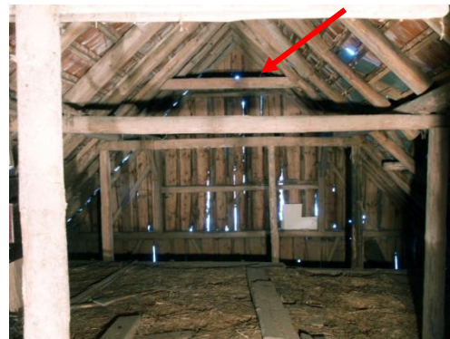
Abb. 64 Dachwerk über dem Wirtschaftsteil, Blick nach Norden
