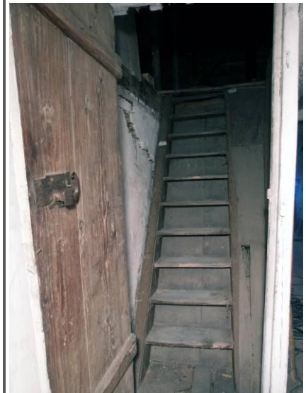
Blick in den Stiegenkasten mit der Treppe zum Dachgeschoss
