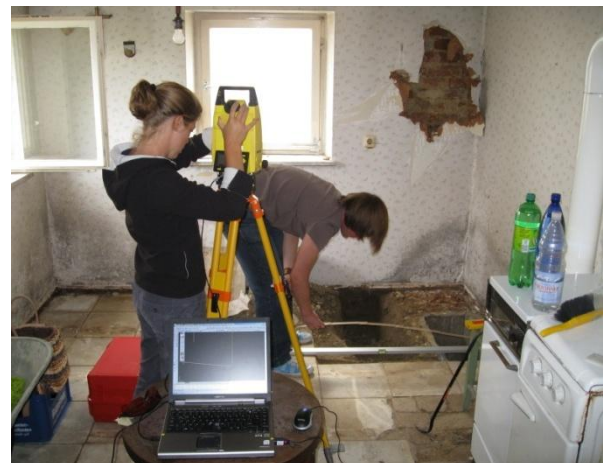
Abb. 56 Die Verfasserin und ein Architekturstudent bei der Vermessung der Küche, an den Tachymeter ist ein Laptop angeschlossen, im AutoCAD kann die entstehende Zeichnung verfolgt werden.
