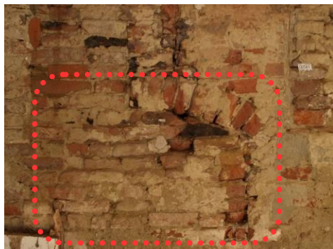
Abb. 36 Zugesezte Öffnung des ehemaligen Backofens in Wand der Küche (Raum 005)
