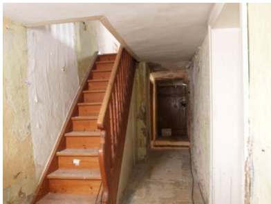
Abb. 40 Flur im EG, Blick nach Osten
