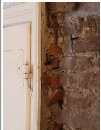
Mit Ziegeln und Putz wurde die bestehende größere Wandöffnung einer Vorgänger-Tür verfüllt.
