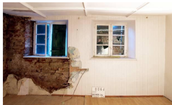
Abb. 25 Stube, Westwand mit Resten der neuzeitlichen Wandverkleidung
