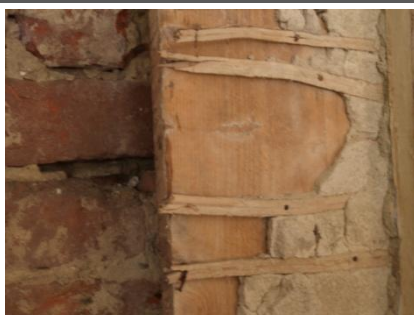
Detail Putzträger, Bretter mit horizontal aufgenagelten Ruten und Putz.
