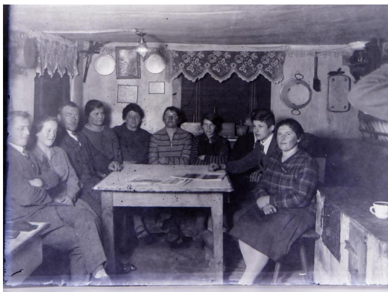
Abb. 28 Historische Aufnahme der Küche, Blick nach Süden. Fensterposition in Nord- und Ostwand erhalten. Die Decke wurde in jüngerer Zeit entfernt und durch eine Spanplattenkonstruktion ersetzt. Vorne rechts im Bild ist ein gemauerter Herd zu erkennen.
