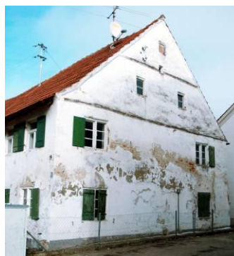
Sölde, Ansicht Süd
