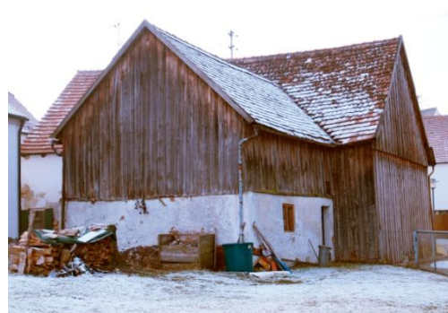
Sölde, Ansicht Nordost
