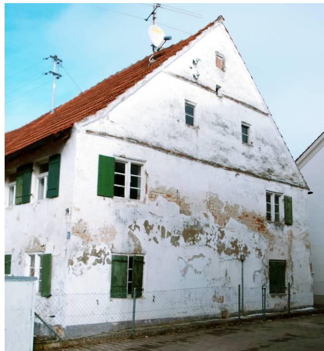
Abb. 2 (oben) Sölde, Ansicht von Westen Abb. 3 (unten) Sölde, Südfassade
