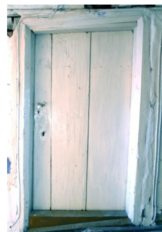
Abb. 52 Bauzeitliche Brettertüre im Raum über der Küche.
