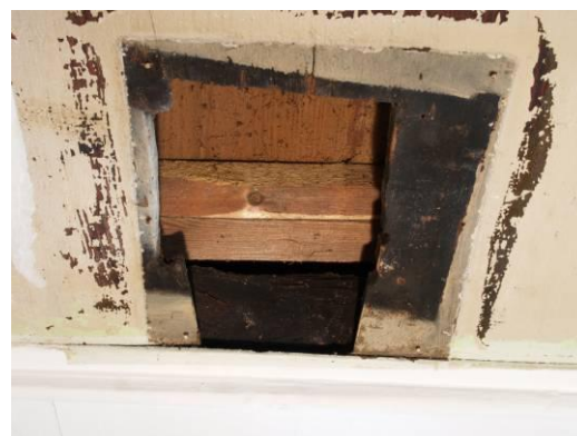
Abb. 27 Blick in das „Spundloch“ in der Felderdecke. Unten ist der rußgeschwärzte Deckenbalken mit Nut zu erkennen, darüber die neu eingefügten Dachlatten, auf welchen heute die Spundbretter aufliegen. Bei dieser neuen Unterkonstruktion für den Boden im Zimmer über der Stube wurde die Position der Spundbretter verändert, deshalb befindet sich hier jetzt ein Brett ohne verrußte Oberfläche und ohne Spundloch, welches vorher bis den darüber liegenden Raum durchging.
