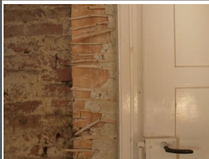
Putzträger mit Ruten läuft hinter die Zierbekleidung.
