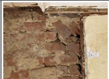
Ansatz des Mauersturzes über dem zugesetzten Fenster F 1006c . Mauersturz bezieht sich auf ein älteres Fenster, Fensteröffnung war ursprünglich kleiner.
