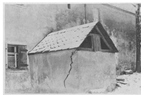
Abb. 39 Fattigau (Lkr. Hof), Backofen erkerartig angebaut, unter dem Dach verbirgt sich die dick mit Lehm verschmierte Kuppel.
