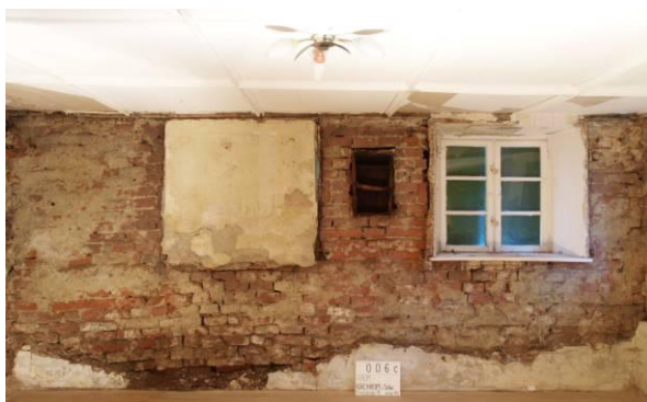
Abb. 24 Stube, Südwand mit zugesetztem Fenster und „Wandkastl“.
