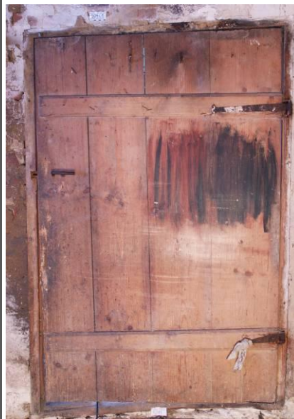
T001/004, Ansicht in Raum 004
