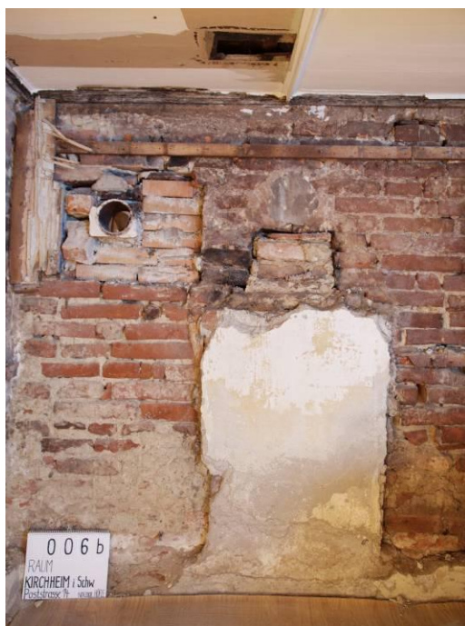
Abb. 26 Ehemalige Position des Stubenofens, links oberhalb davon zugesetzte Durchreiche.
