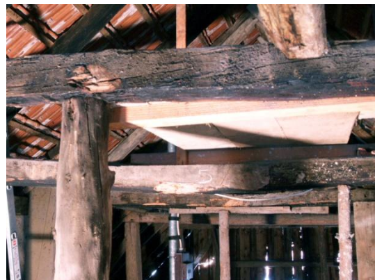
Abb. 55 Dachgeschoss, Blick nach Norden, gebrochene Kehlbalken, durch Rundhölzer gestützt
