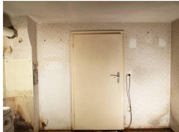
Abb. 30 Nordwand, vor Abnahme der Wandverkleidung aus Spanholzplatten
