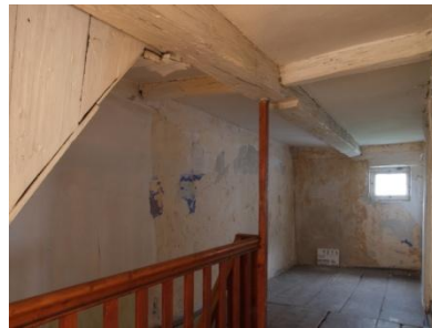
Abb. 41 Flur im OG, Blick nach Osten
