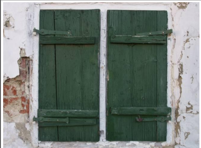
F 2 006d Außenansicht
