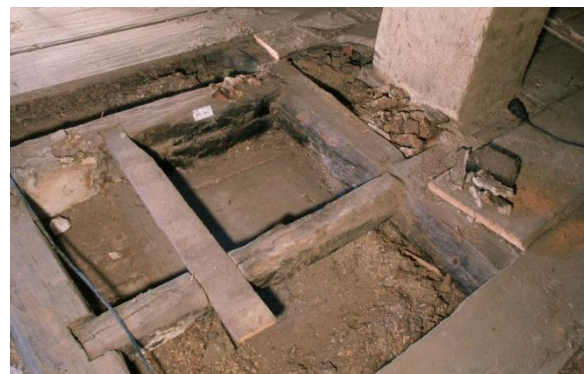
Abb. 35 Situation im Dachgeschoss, nach der Entfernung einiger Dachbodenbretter ist die ehemalige Kaminsituation erkennbar.
