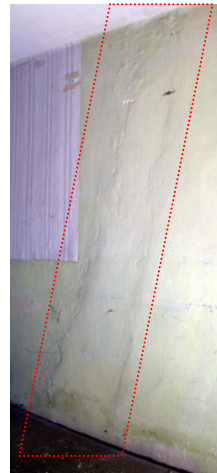
Abb. 34 Abdruck des ehemaligen Schlotes auf der Westwand in Raum 103 über der Küche. Im Streiflicht ist die Breite der südlichen Begrenzung des Schlotes erkennbar (rote Markierung), die nördliche Begrenzung liegt ca. 40 cm südlich des neuen russischen Kamins.
