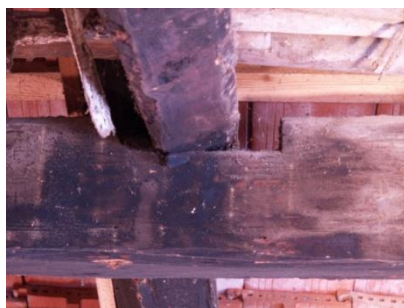
Links Abb. 56 Östliches Rähm, Gespärre 3, Auskerbung und Kehlbalken; Mitte Abb. 57 Östliches Rähm, Gespärre 2, Auskerbung und Kehlbalken; Abb. 58 Östliches Rähm, Kopfband an Stuhlsäule 1, Verblattung
