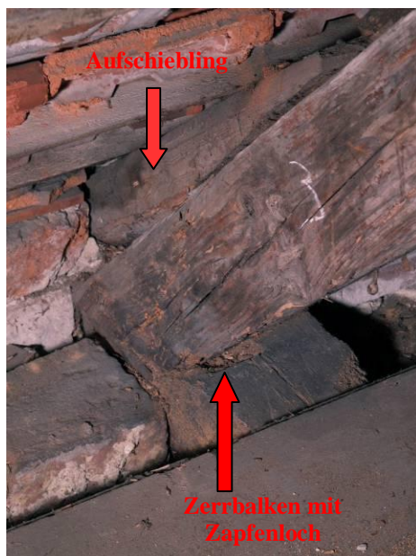
Abb. 16 Westlicher Fußpunkt von Sparren 3
