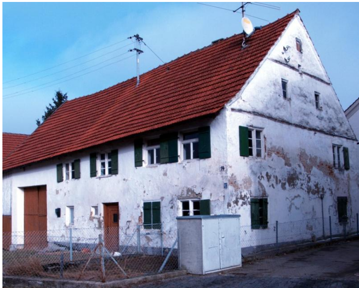
Abb. 1 Ansicht Sölde von Süd-West
