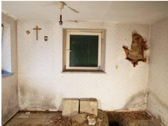
Abb. 29 Südwand, vor Abnahme der Wandverkleidung aus Spanholzplatten
