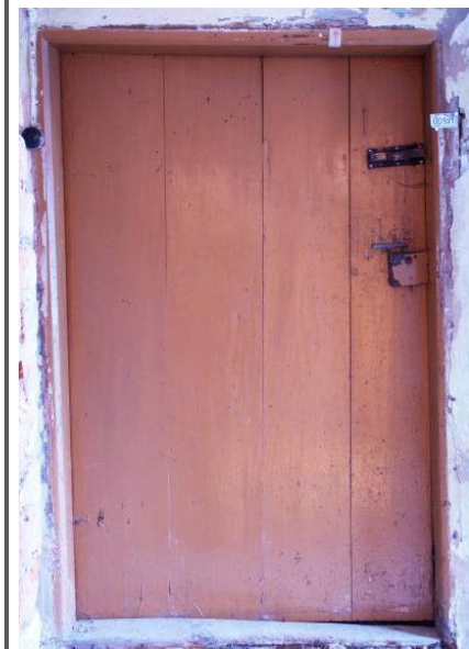
T001/004, Ansicht in Raum 001
