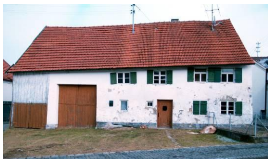
Sölde, Ansicht West
