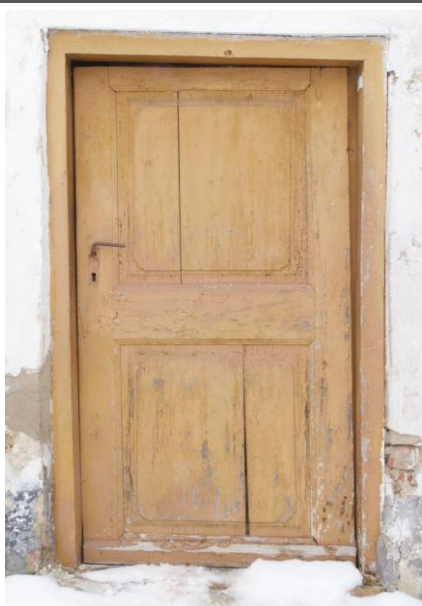
Haustür Ost, Außenansicht
