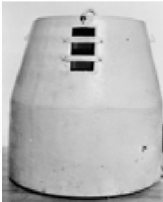
**Abbildung 1-2: Die „Regener Tonne“ – Erste Nutzlast der A4 zur Erforschung der Atmosphäre [Globig, [40], 2006]**
