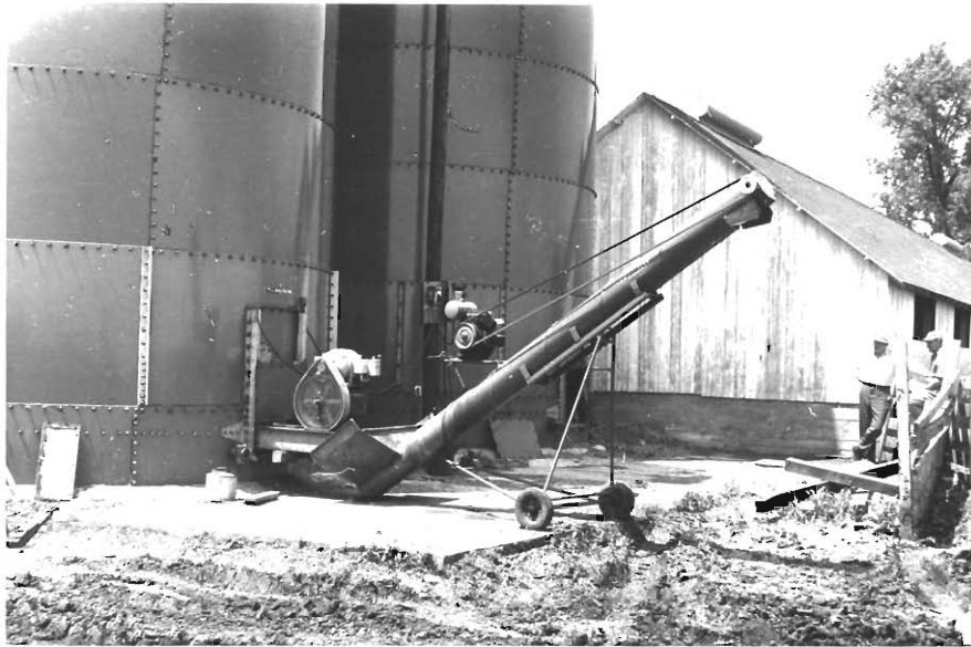
Abb. 7: Entleerungsmöglichkeit am Fuss des emaillierten Stahlblechsilos
