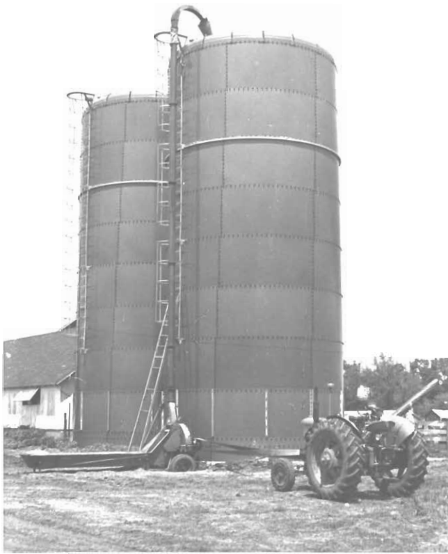
Abb.6: Luftdichte, emaillierte Stahlblechsilos mit Wurfgebläse zur Befüllung
