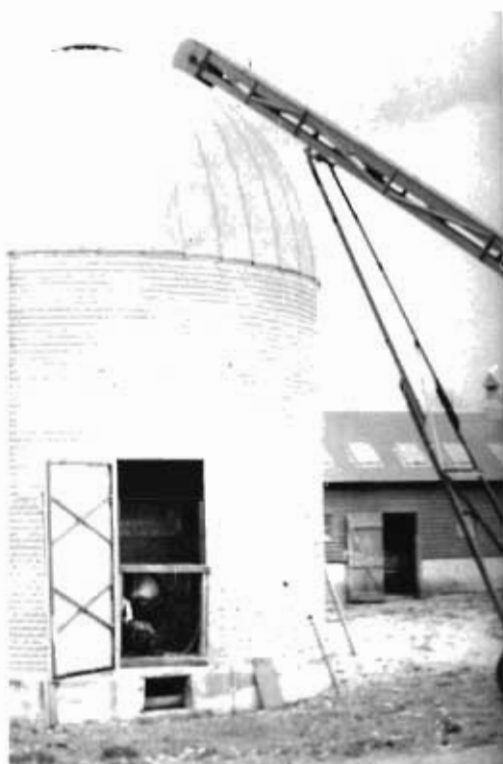
Abb. 2: Stahlblechturm mit perforierter Aussenwand zur künstlichen Trocknung von Maiskolben und Heu
