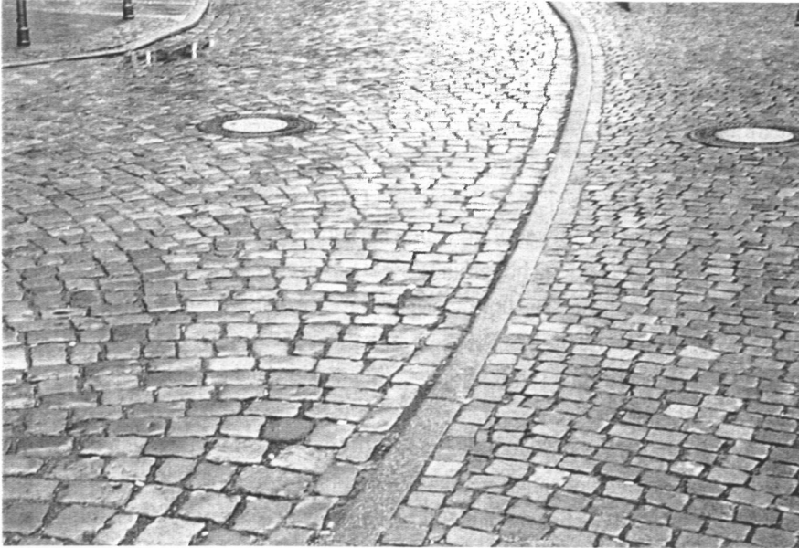
Bild 2. Gleicher Wegbelag Gehweg/Fahrbahn: Ein nicht klar abgegrenzter Verkehrsraum kann eine Barriere darstellen (Bild: TU München).
