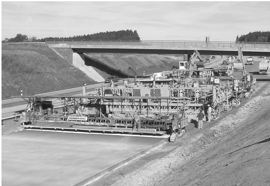
Abbildung 16: Herstellen einer Betonfahrbahndecke mittels Gleitschalungsfertiger
