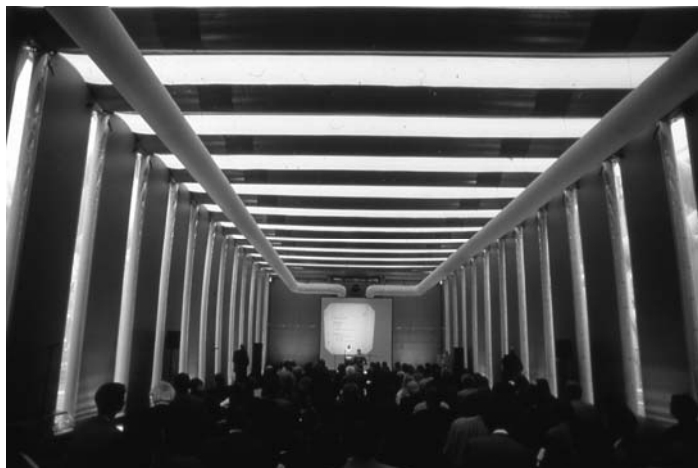
Abb. 1.21 FESTO Pneuhalle "AIRTECTURE", ETFE-Unterdruckpneus, Esslingen, 1996 [184]
