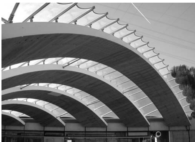
Abb. 1.30 E.ON Informationszentrum Walchenseekraftwerk, Kochel am See, 2001, Foto: K. MORITZ
