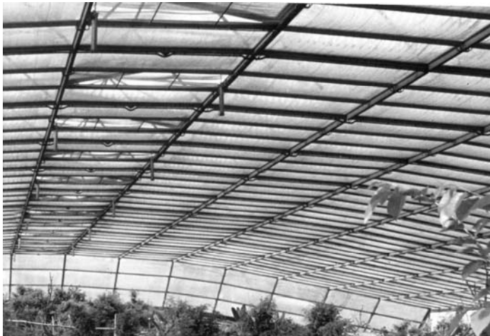
Abb. 1.18 Mangrovenhalle im Burger's Park, erste permanente Halle mit ETFE-Pneus, Arnheim, 1982 [79]
