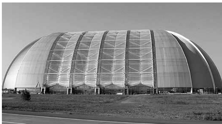
Abb. 1.27 Freizeitbad "Tropical Island" (Umbau der CargoLifter Werfthalle in Briesen bei Brand, Brandenburg), 2005 [157]
