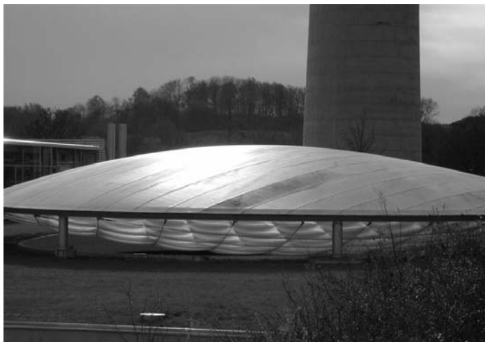
Abb. 1.20 Münchner Olympiagesellschaft MOG – Hublinse, ETFE-Folienpneu auf Seilnetz, München, 1996, Foto: K. MORITZ
