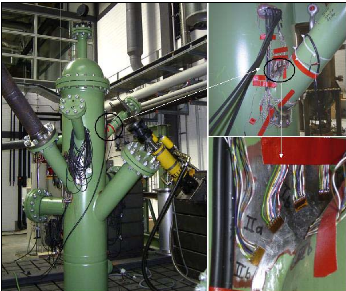
Abb. 6.21: Versuchsaufbau und Messstellen
