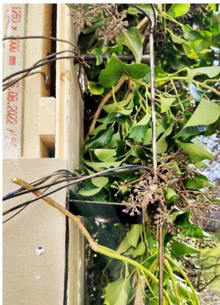
Abbildung 4.4 Fotodokumentation der Seitenansicht mit Anordnung der Begrünung und Brandsperre
