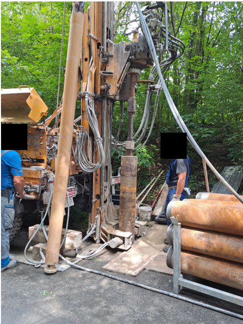
Abbildung 2.1 Erkundungsbohrung (eigene Aufnahme am 23.07.2024)
