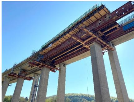
**Abb. 1** Abschnittsweiser Rückbau des Überbaus der Talbrücke Unterrieden auf Vorschubrüstung
