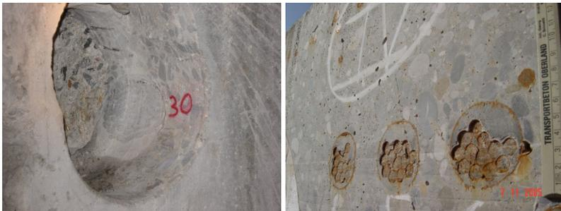
**Abb. 3** Links: Abgebohrtes Längsspannglied; Foto: Adam Hörnig Baugesellschaft mbH, rechts: Planmäßiger Einzug von durchtrennten Spanngliedern
