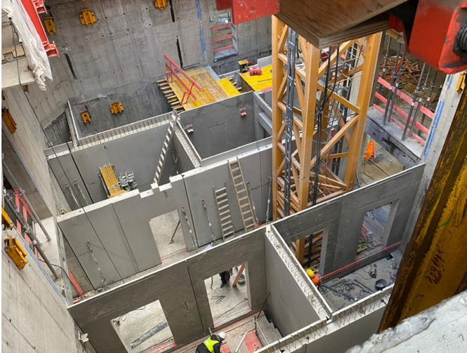
**Abb. 9:** Kernwände als Betonfertigteile
