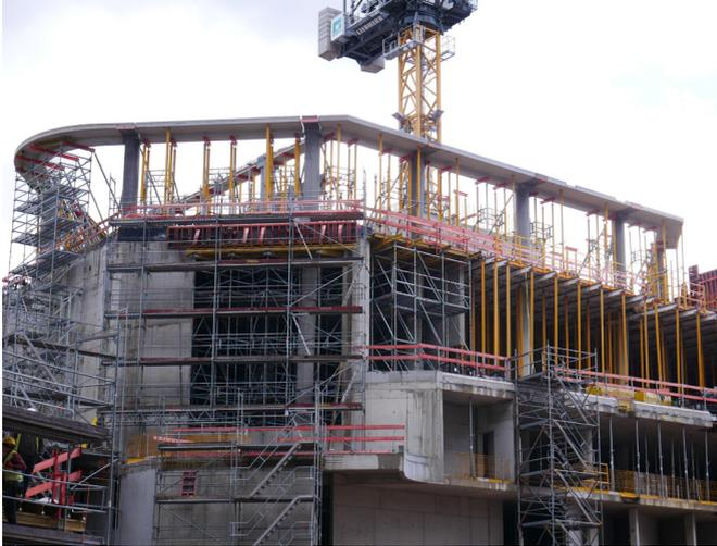
**Abb. 5:** Montagezustand der Halffertigteildecke
