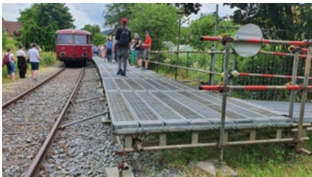
Abb. 3 Passau Rosenau – provisorisch installierter Behelfsbahnsteig in Gerüstbauweise.
