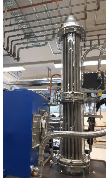
(b) Rückseite des Absorbers und Fallfilmverdampfer
