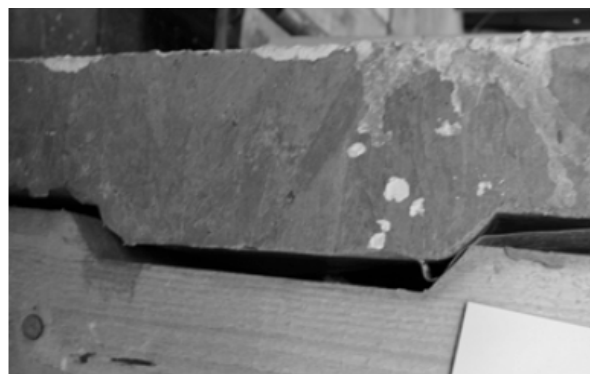
Abb. 5-5: Verbundversagen durch Abrutschen im HBV, aus [11]
