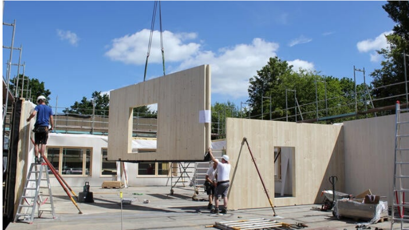
Abb. 2-5: Baustellenseitige Anlieferung eines Wandelements aus BSP. Foto: Brüninghoff, aus [6]
