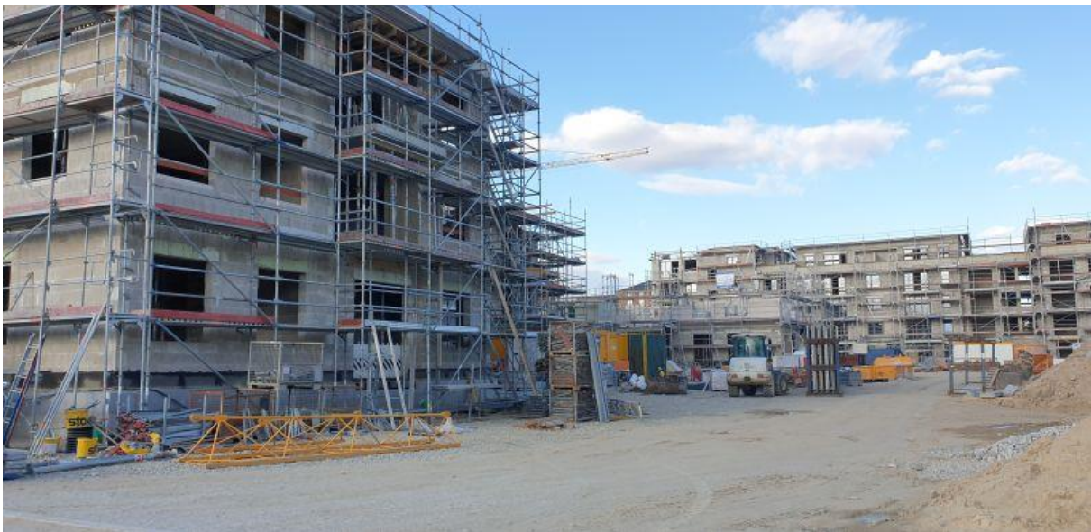
Abbildung 63: Baumaßnahme in Bamberg im Juli 2022. Ausführung Rohbau (fatkoehl)
