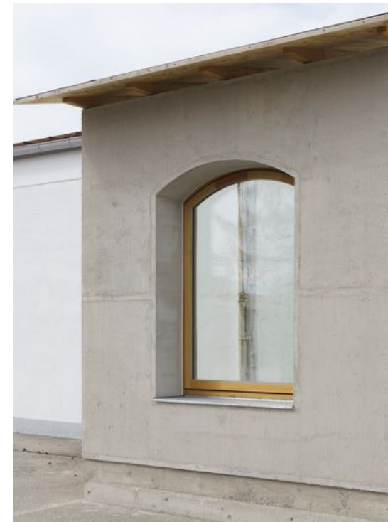
39 16 Bogenfenster im Betonhaus, Rechteck im Holzhaus, Segmentbogen im Mauerwerkshaus; Aufnahme von den Fassaden-Mock-Ups, die in Vorbereitung auf den Bau der Häuser entstanden (Fotos: S. Schels)
