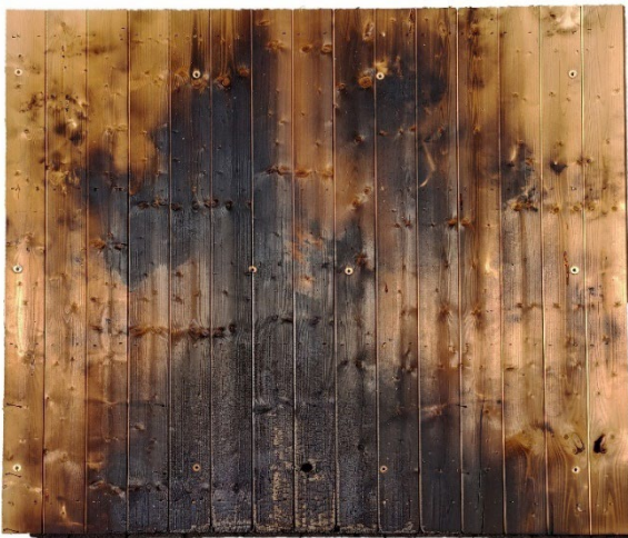
Abbildung 7: Fotodokumentation der Holzschalung oberhalb der Brandsperre nach Beendigung des Versuches und der Beobachtungszeit für Test 3
