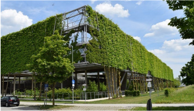
Abbildung 2: Bodengebundener Bewuchs an Kletterhilfen (Swiss Re Bürogebäude München); (Quelle: Bundesverband GebäudeGrün)
