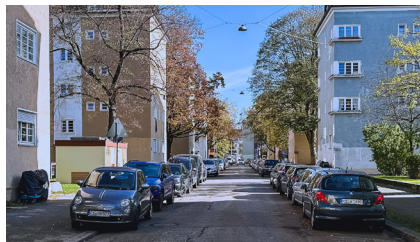
Abb. 9: Straßenquerschnitt Landstraße vor der Umgestaltung
