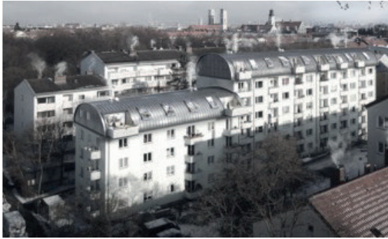
Abb. 7.2 Aufstockung mit Tonnendach, Demleit- nerstraße
