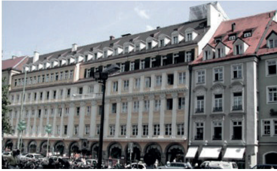
Abb. 7.1 Dachausbau mit vorgesetz- ten Gauben, Marienhof
