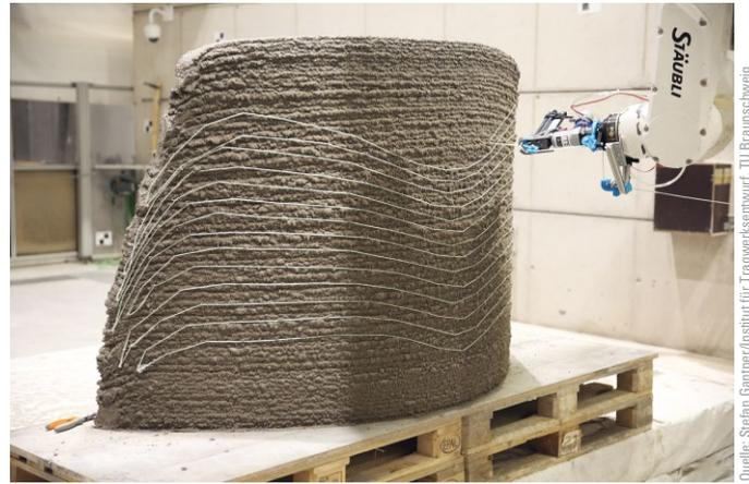
**Bild 3** Robotisches Aufbringen von Faserbewehrung auf einen im SC3DP-Verfahren gefertigten Wandkern
