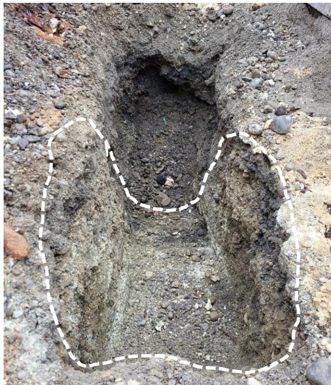
[Abb. 7.14](#): Schurf zur Beurteilung der Ausbreitung des Injektionsmaterials
