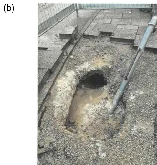
Abb. 7.1: Schadensbilder vom U-Bahnhof Holzapfelkreuth: (a) Asphalttrisse parallel zur Treppenanlage Nordwest; (b) Einsenkungen unter dem Pflaster bei der Treppenanlage Südost, entnommen aus Berichten des Baugeologischen Büro Bauer (2020) und (2022)
