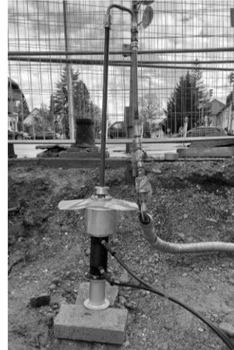
Abb. 7.5: Baustelleneinrichtung für die Schauminjektion: (a) Zweikomponentenpumpe; (b) Automatische Ziehvorrichtung für den kontinuierlichen Rückbau der Rammlanzen
