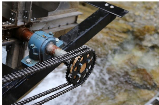
Abbildung 6.10: fertiges Kettengetriebe - Wasserradseite
