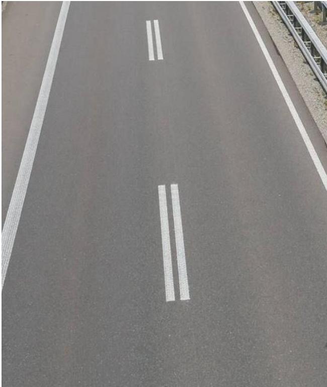
Abbildung 110: Markierung Managed Lane im Verflechtungsbereich
