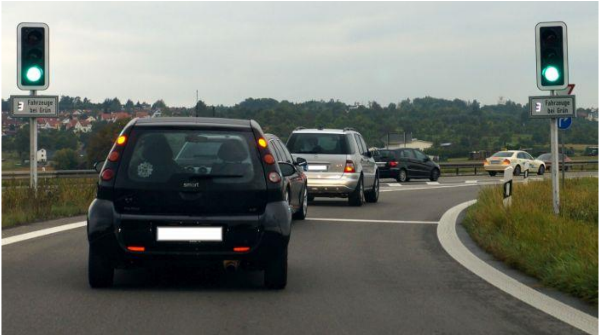
Abbildung 16: Praxisbeispiel Zuflussregelung (Straßenverkehrszentrale Baden-Württemberg 2018)
