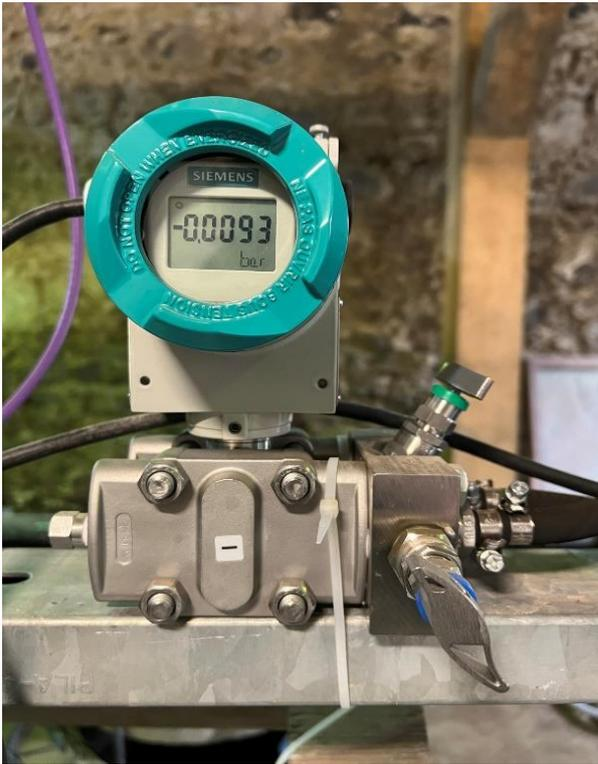
**Abbildung 14:** Differenzdruckmessgeräte vom Typ Sitrans P DS III zur Aufnahme des Differenzdruckes
