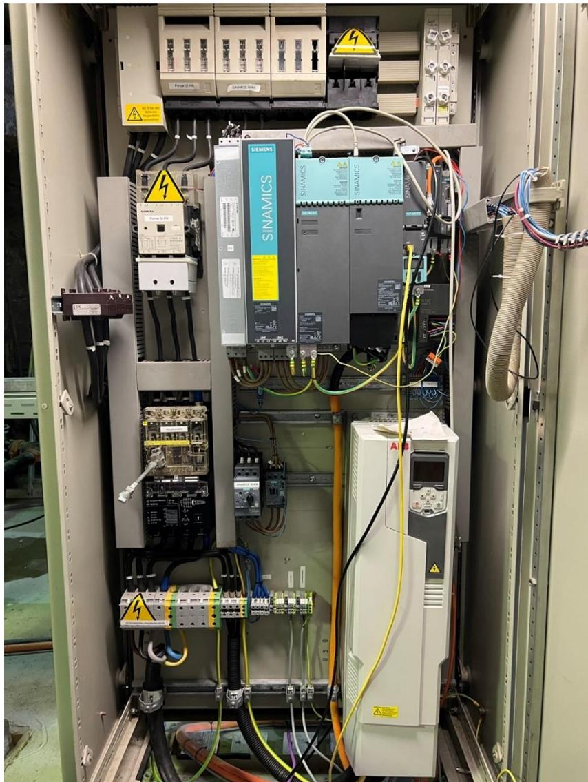
**Abbildung 11:** Elektrischer Aufbau des Turbinenprüfstandes mit Sicherheitseinrichtungen, rückspeisefähigem Siemens S120 Frequenzumrichter (mittig) zur Drehzahlregelung der PAT und ABB ASC580 Frequenzumrichter (unten rechts) zur Drehzahlregelung der Gefällepumpe
