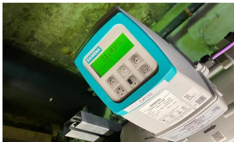
**Abbildung 12:** Magnetisch-induktives Durchflussmessgerät zur Messung des Durchflusses SITRANS F M MAG 5100 W
