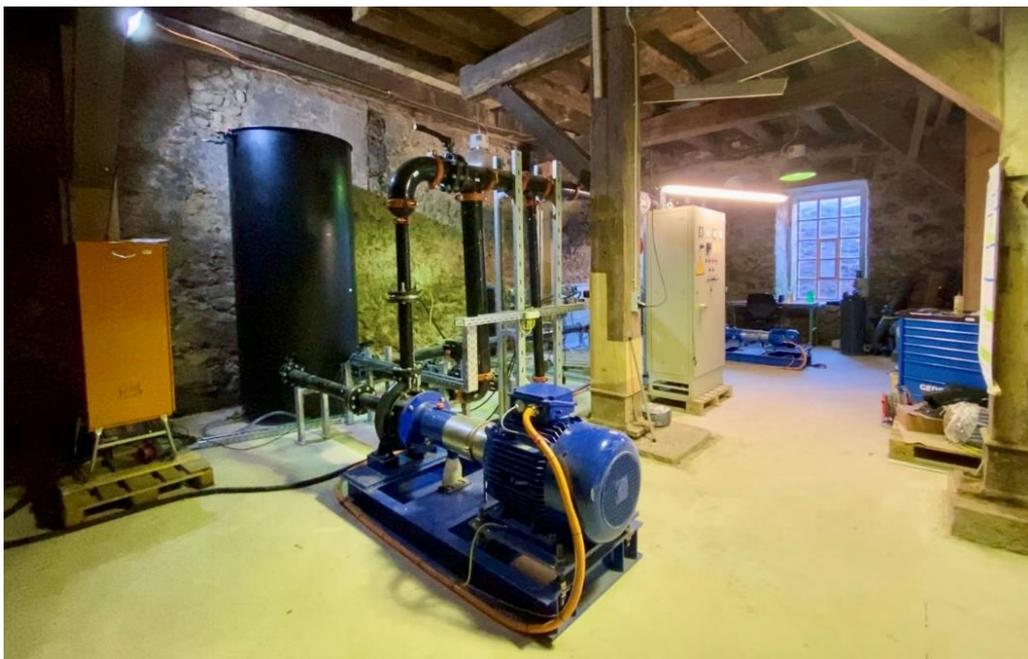
**Abbildung 10:** Bild des Turbinenprüfstandes in der Seebachschleife am Fuße des Arbers
