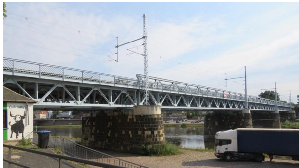
Abbildung I.1.: Ansicht Elbebrücke Meißen
