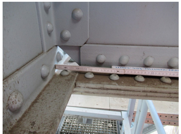
(b) Kreuzung Längsträger - Querträger
