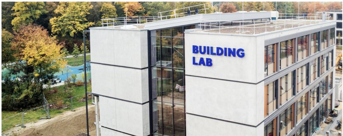
Abbildung 23 Building Lab. Außenansicht des Endzustandes im November 2022, aus der Vogelperspektive [19].
