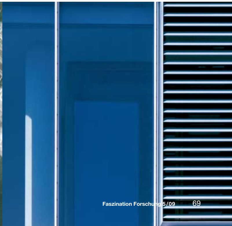
Metall-Glas-Fassade mit Lüftungslamellen, Hochhaus Deutsche Messe AG, 1999
