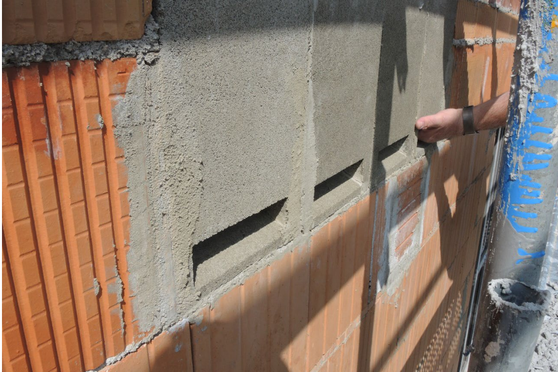
Abb. 1.2-2: Einbau der Fledermausquartiere, Produkt der Fa. Hasselfeldt (Bild: Sylvia Weber, LBV)
