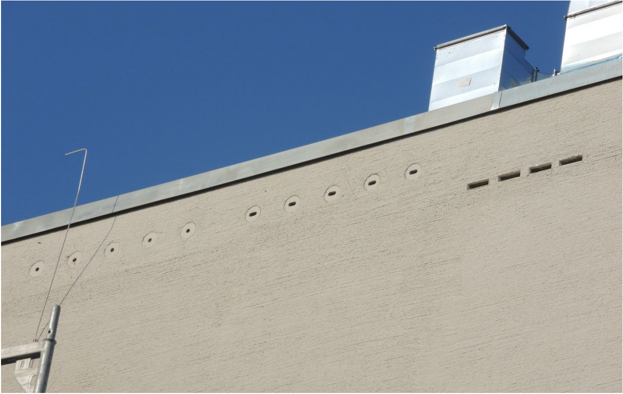
Abb. 1.1.-6 Fertig eingebaute Fassadenquartiere (Bild: Sylvia Weber, LBV)
