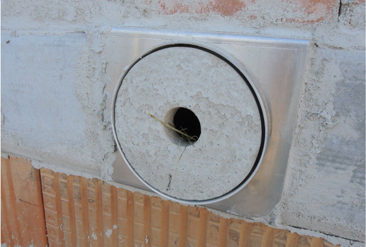
Abb. 1.1.-5 Rosette mit WDV-Aufsatz und Heu als Nisthilfe für Sperlinge (Bild: Sylvia Weber, LBV)
