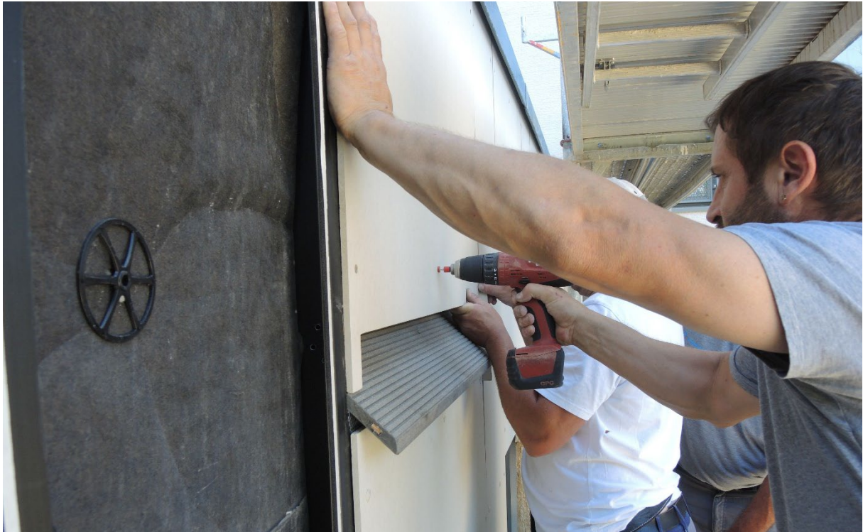
Abb. 1.2-16: Einbau der Abdeckplatten an den Einkammerkästen für Fledermäuse (Bild: Sylvia Weber, LBV)
