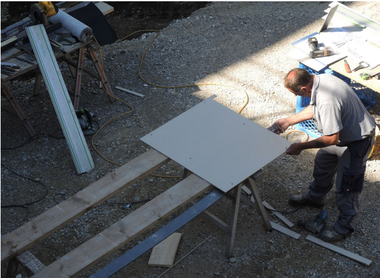
Abb.1.2-13 : Zuschnitt der Abdeckplatten auf der Baustelle (Bild: Sylvia Weber, LBV)
