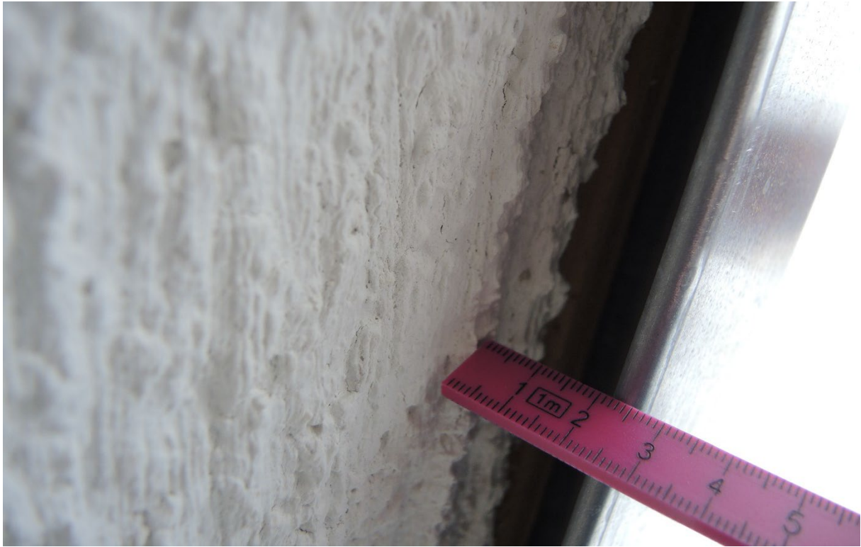
Abb. 1.2-26: Kontrolle des Blechabstandes der Fledermausspalten (Bild: Sylvia Weber, LBV)
