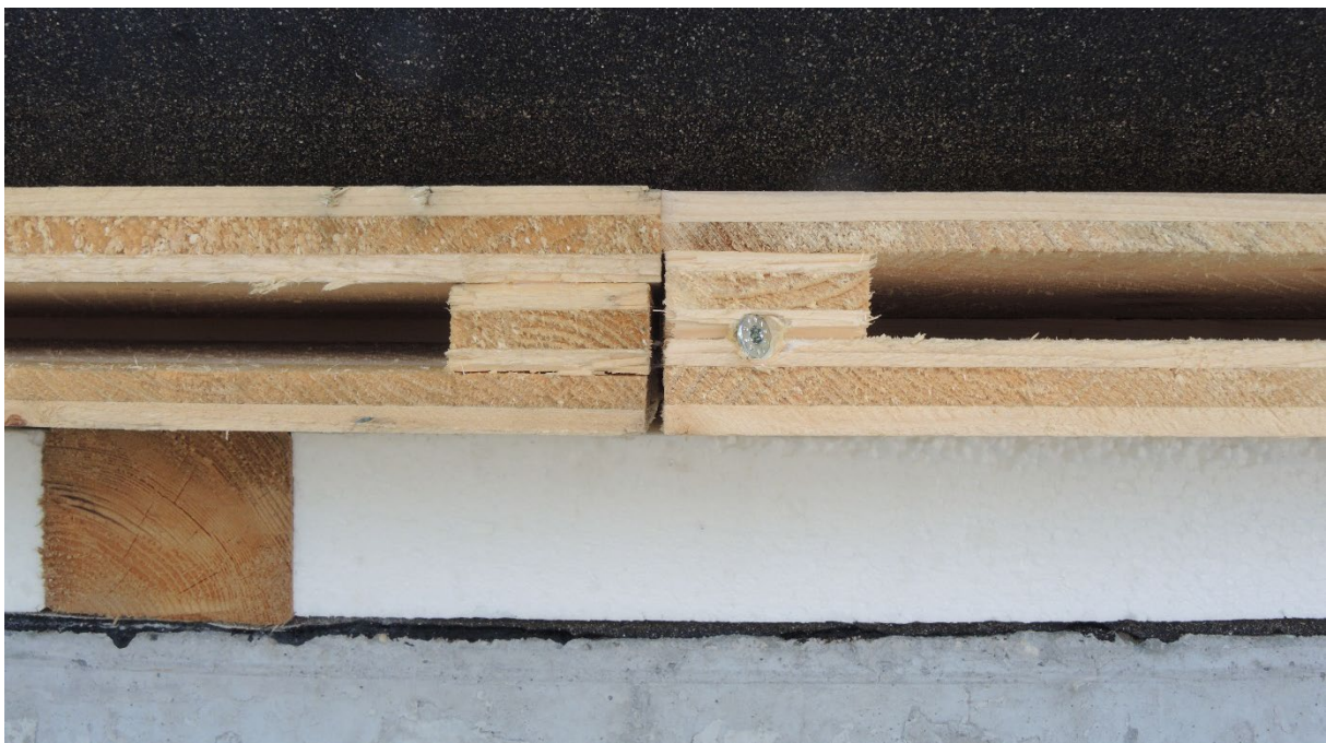
Abb. 1.2-23: Kontrolle des Einbaus der Fledermausspalten, links richtiger Einbau, rechts falscher Einbau (Bild: Sylvia Weber, LBV)
