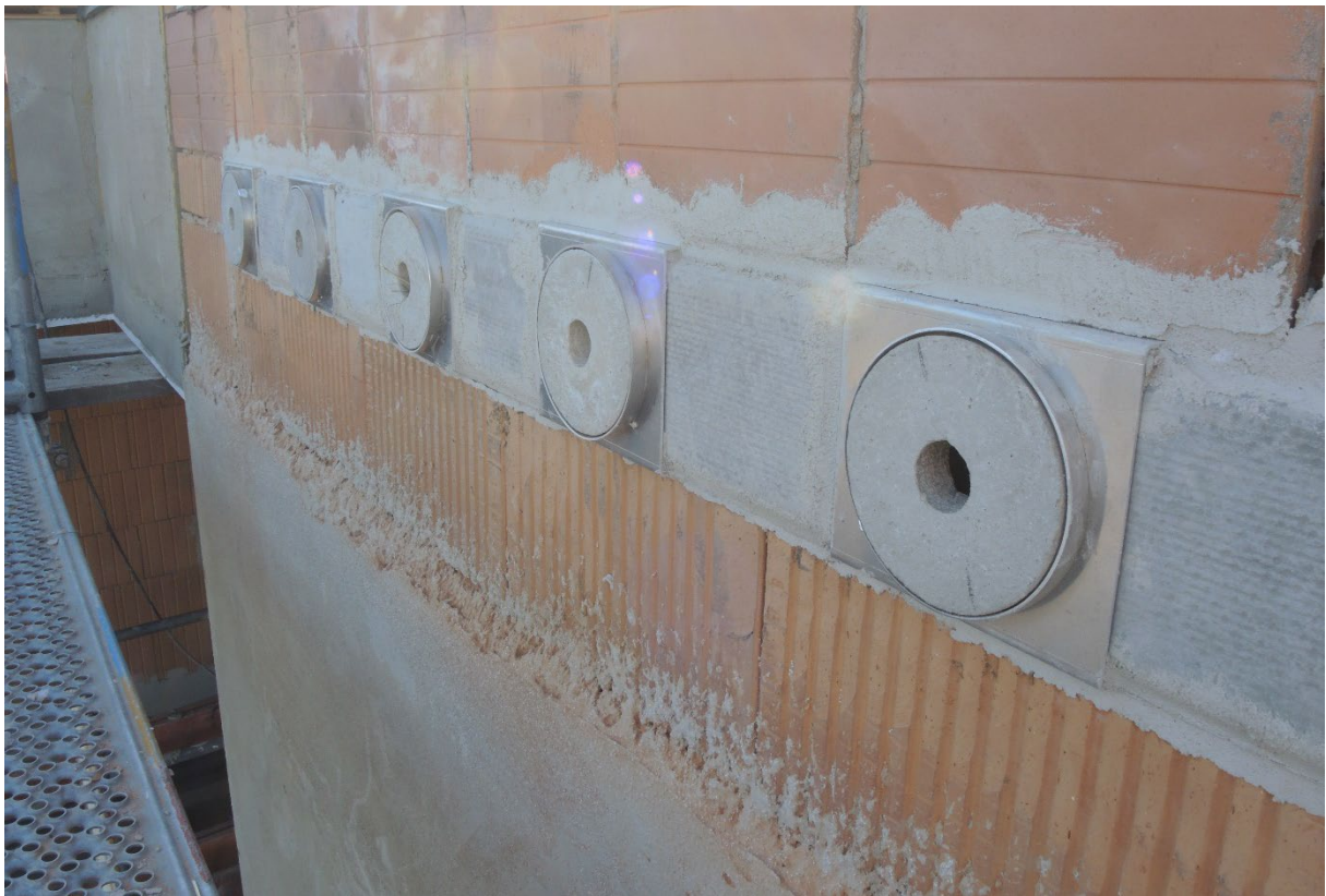
Abb. 1.1-4: Rosetten mit WDV-Aufsatz (Bild: Sylvia Weber, LBV)
