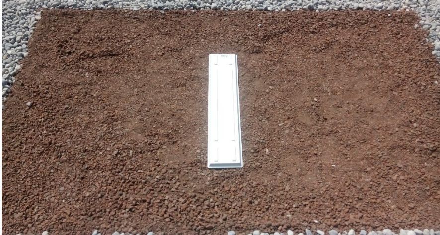
Abb. 2.5-8: Kapillarsperre auf einer Versuchsfläche in der Brantstraße (Bild: Maximilian Mühlbauer)
