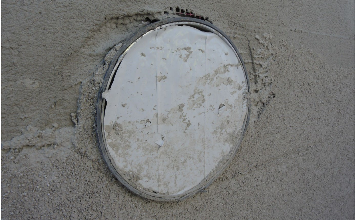
Abb. 1.1-3: Abgeklebte Rosette mit Kompri-Band während der Putzarbeiten (Bild: Sylvia Weber, LBV)
