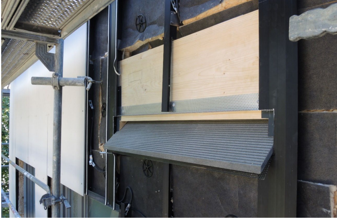
Abb. 1.2-14: Einbau der Einkammerkästen für Fledermäuse (Bild: Sylvia Weber, LBV)
