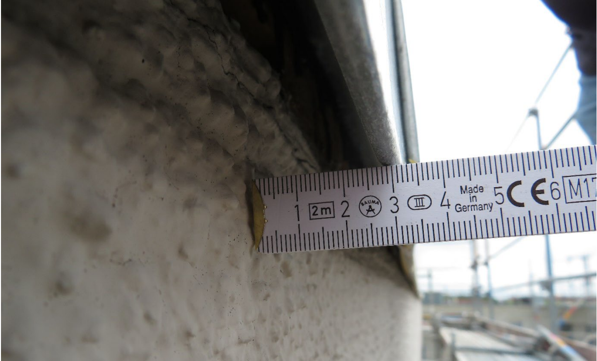
Abb. 1.2-25: Kontrolle des Blechabstandes der Fledermausspalten (Bild: Sylvia Weber, LBV)
