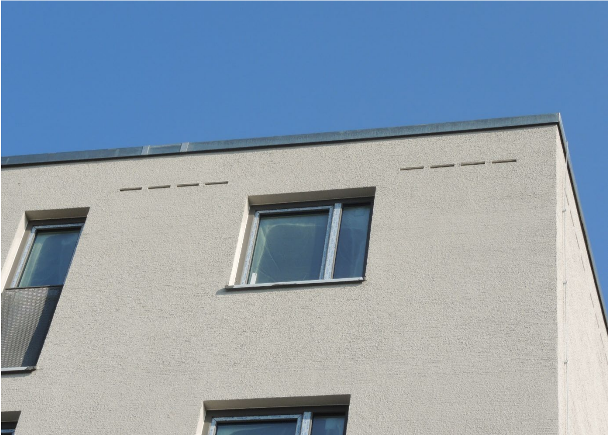
Abb.1.2-6: Fertig eingebaute Fassadenquartiere (Bild: Sylvia Weber, LBV)
