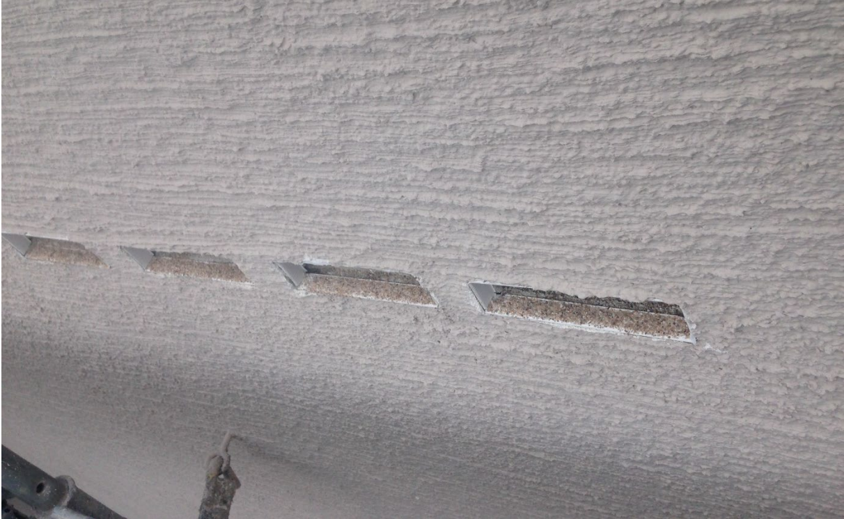
Abb. 1.2-5: Besandung der Einschluflöcher zur Aufrauung der Oberfläche (Bild: Volker Eidner, IB Schmidt GmbH)
