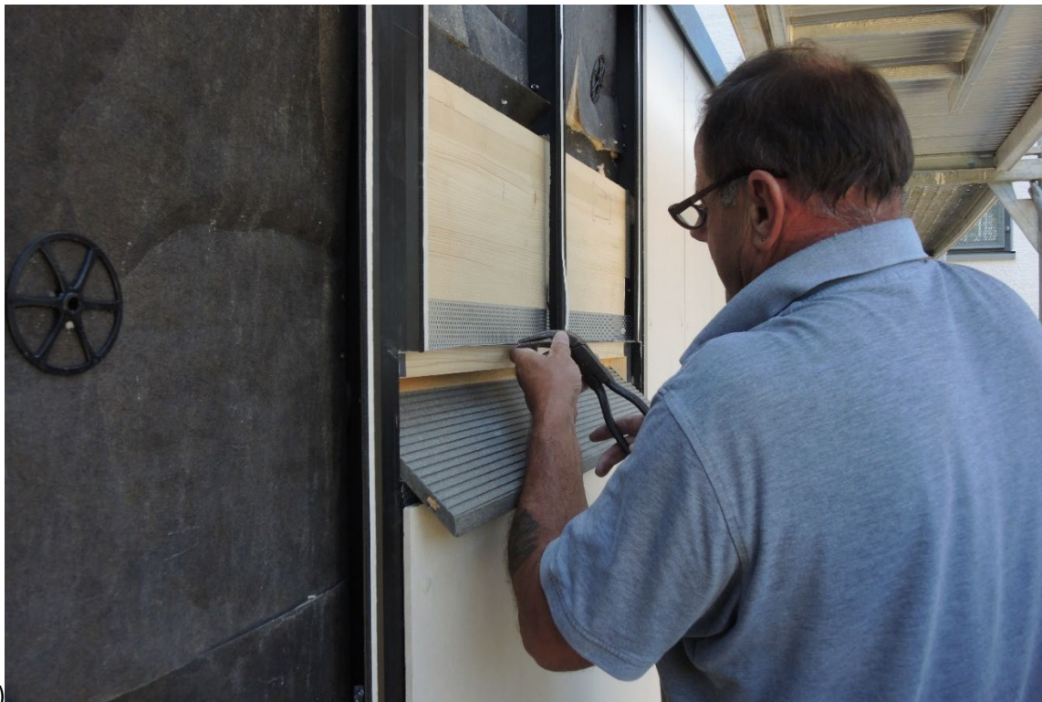
Abb. 1.2-15: Entgratung der Gitter an den Einkammerkästen für Fledermäuse (Bild: Sylvia Weber, LBV)
