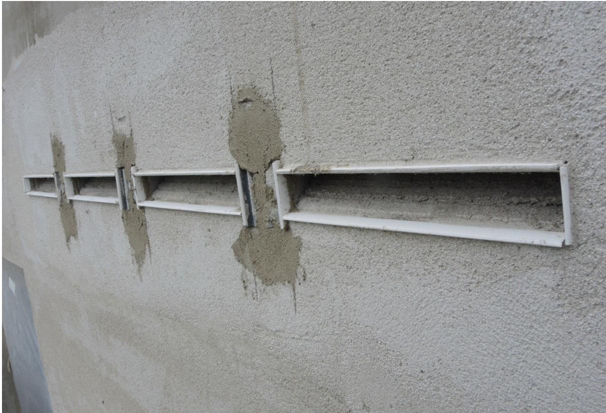
Abb. 1.2-3: Anputzleisten zum Schutz der Fassadenquartiere während den Putzarbeiten (Bild: Sylvia Weber, LBV)
