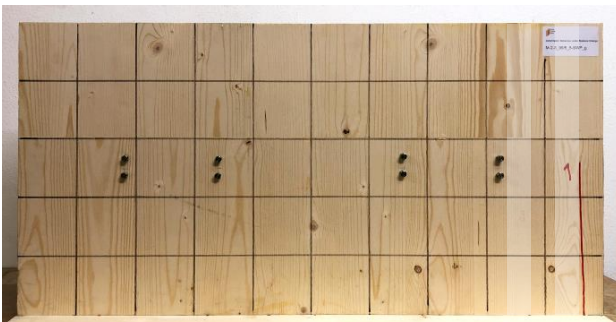
Abbildung A6: Rissbild Prüfkörper M-2-3 (V)
