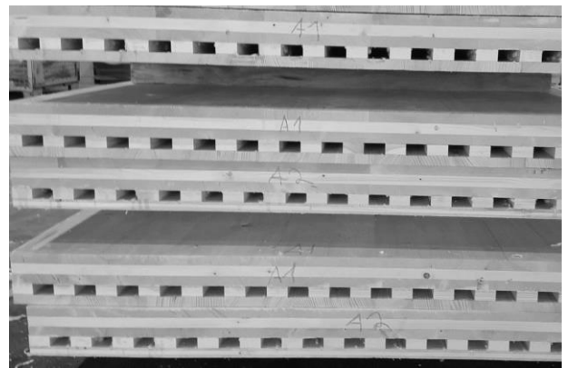
Schnitt durch die fertigen multifunktionalen BSP-Elementen (A1 = Serie M-1, A2 = Serie M.2)
