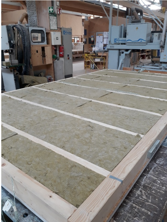
Abb. 13: Holztafelbauwand Steinwolldämmstoff im Gefach – vor dem Aufbringen der Bekleidung
