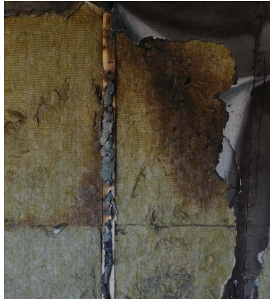
Abb. 8: Verfärbungen an den Befestigungspunkten am Ständer einer Holztafelbauwand, V4
