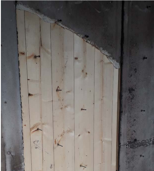
Abb. 7: Verbindungsmittel nach Entfernen der Brandschutzbekleidung, V0
