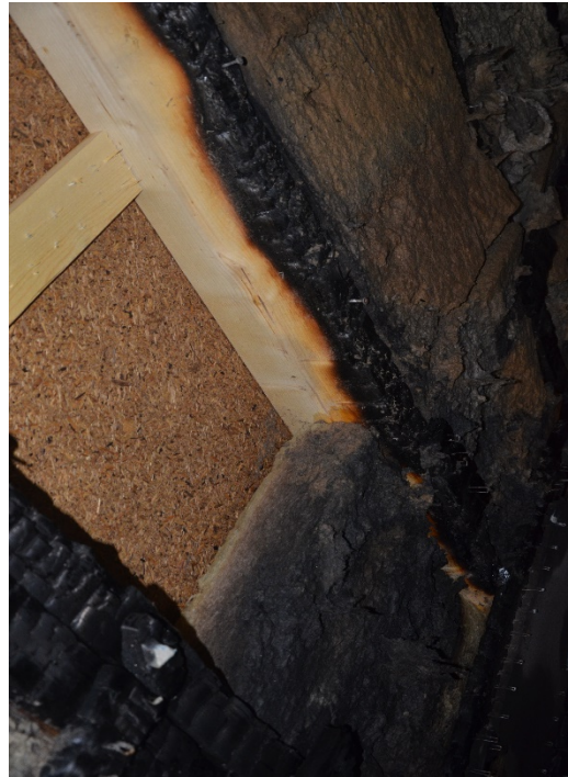
Abb. 14: Schutzwirkung der Steinwolldämmung für die Gefache, V2
