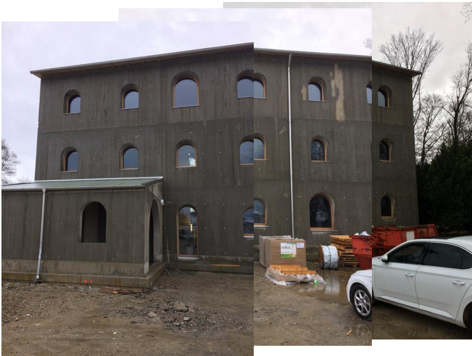
Abbildung 12: Durchfeuchtete Wetterseite am Montag 10.10.2020 um 13 Uhr hervorgerufen durch das Sturmtief Sabine.
