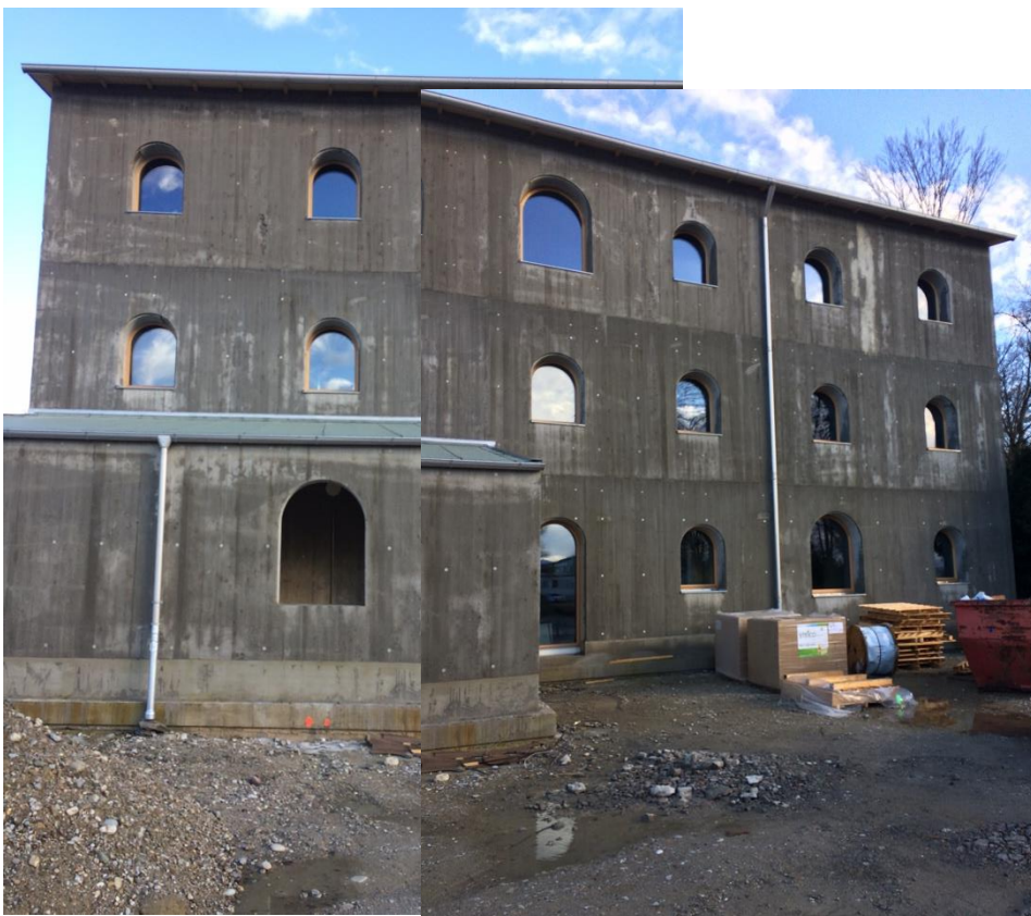
Abbildung 12: Durchfeuchtete Wetterseite am Montag 10.10.2020 um 13 Uhr hervorgerufen durch das Sturmtief Sabine.
