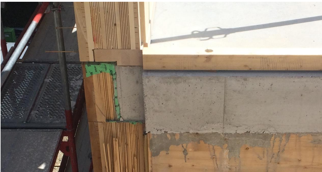
Abbildung 41: Das entsprechende Detail vor Ort in der Umsetzung.
