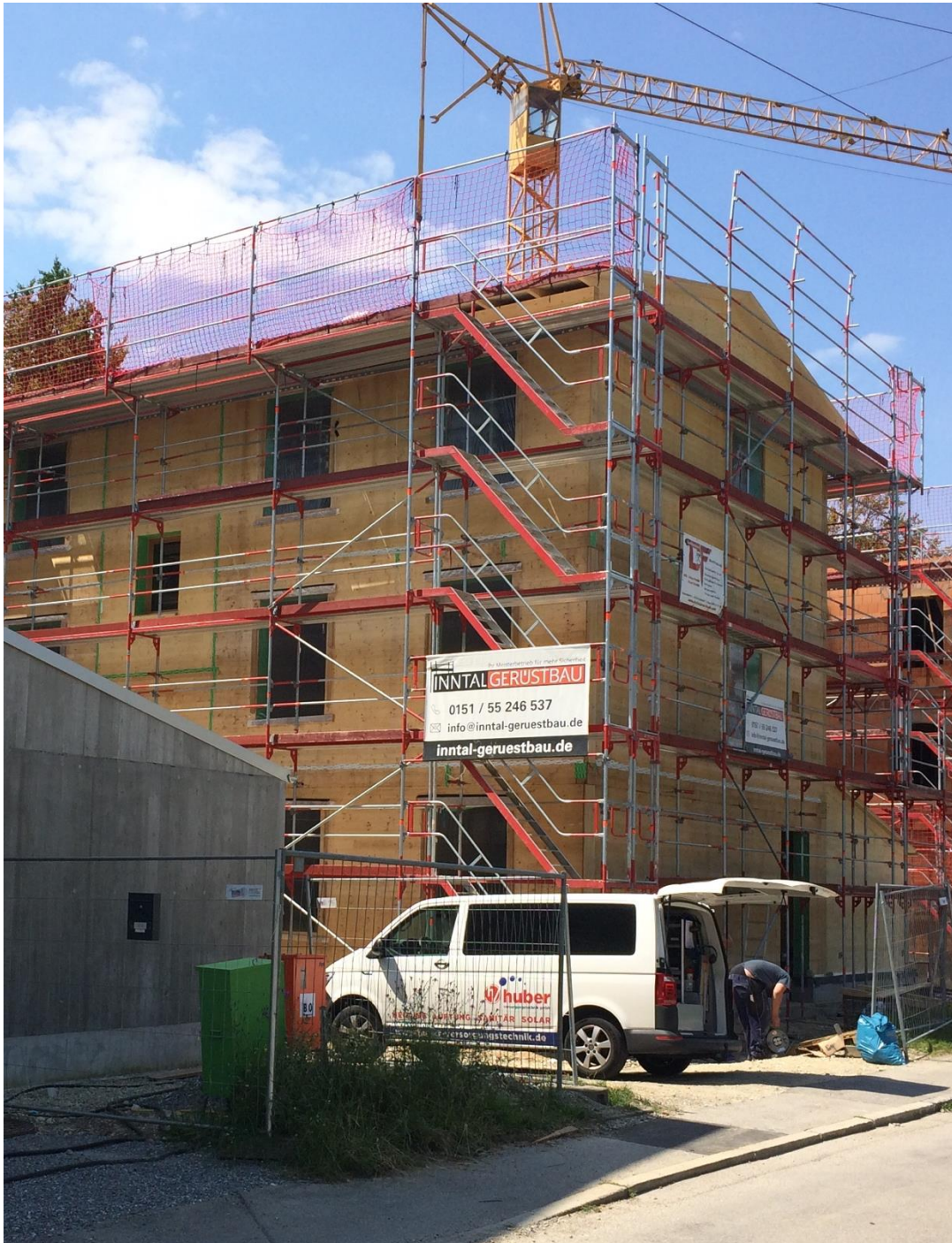
Abbildung 44: Der Dachstuhl ist aufgerichtet.
