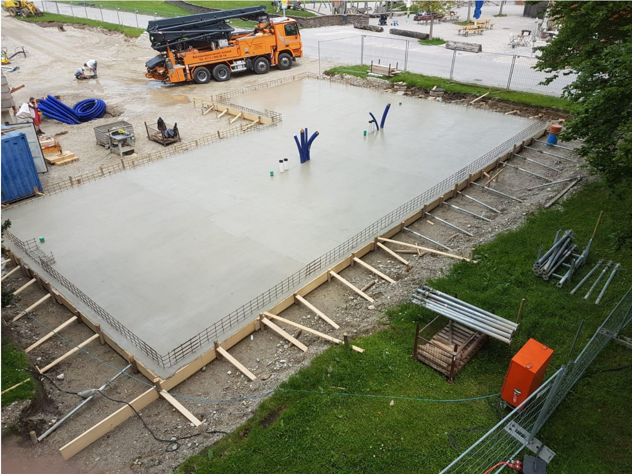
Abbildung 2: Die Bodenplatte ist betoniert.
