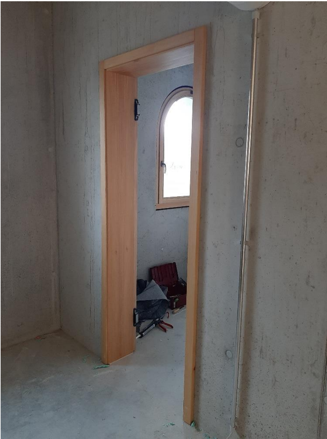
Abbildung 16: Einbau der Wohnungstüren.
