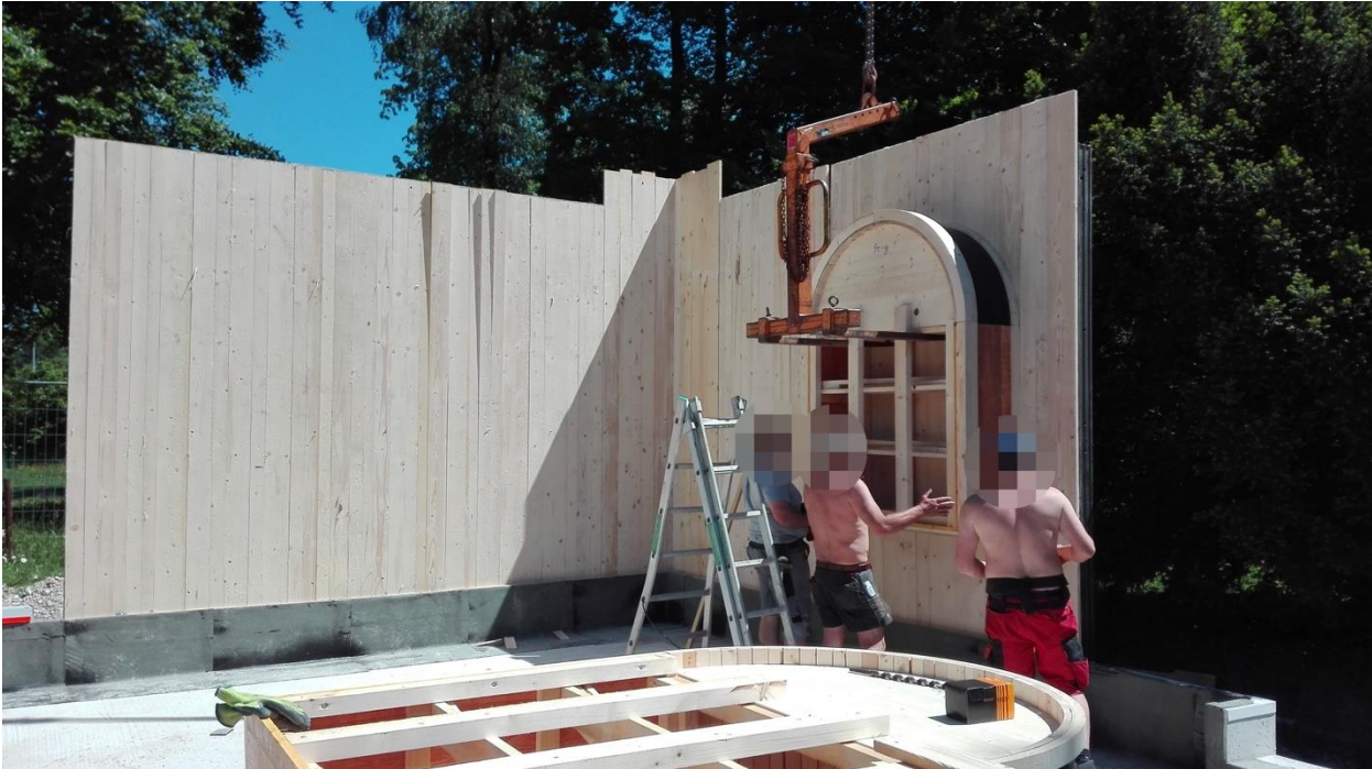
Abbildung 3: Die Schalung für die erste Infraleichtbeton-Wand wird aufgestellt.
