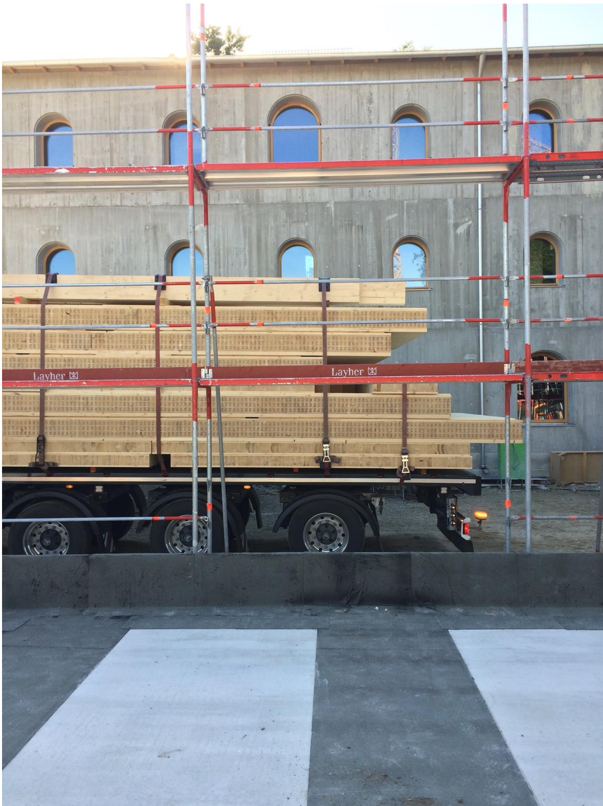
Abbildung 19: Lieferung des Wandteile für das Erdgeschoss des Holzhauses.
