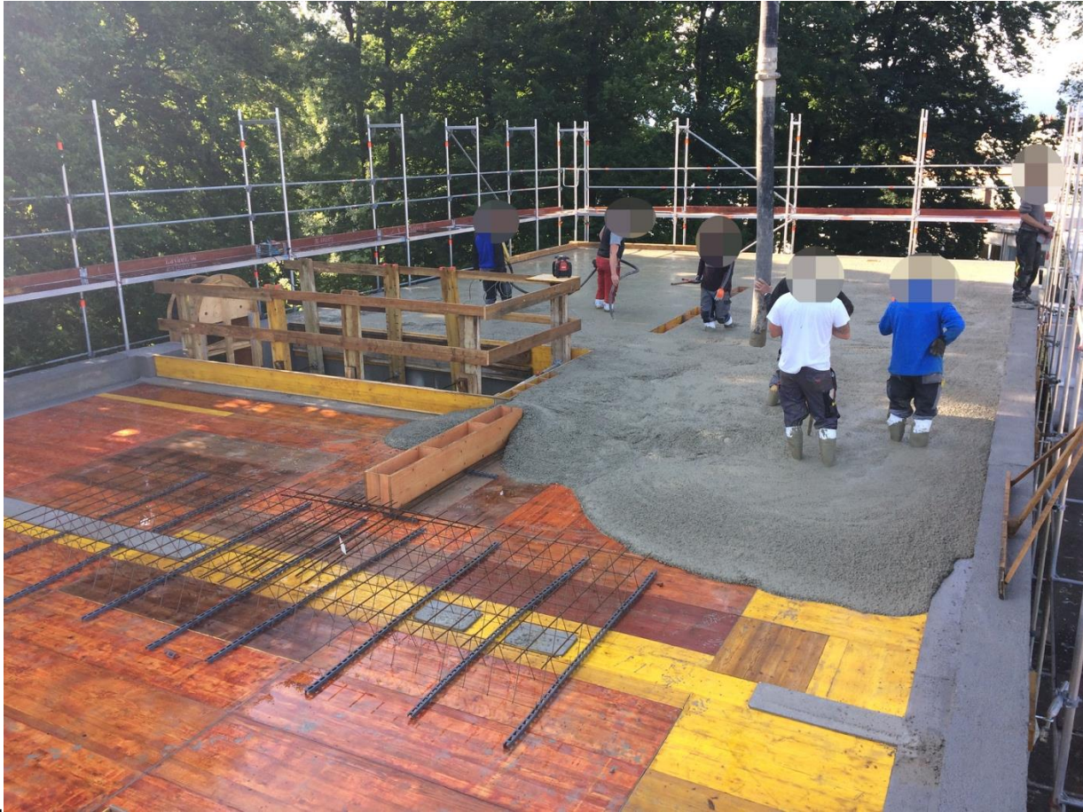
Abbildung 10: Die Decken wurden ebenfalls mit Stahlfaserbeton hergestellt.
