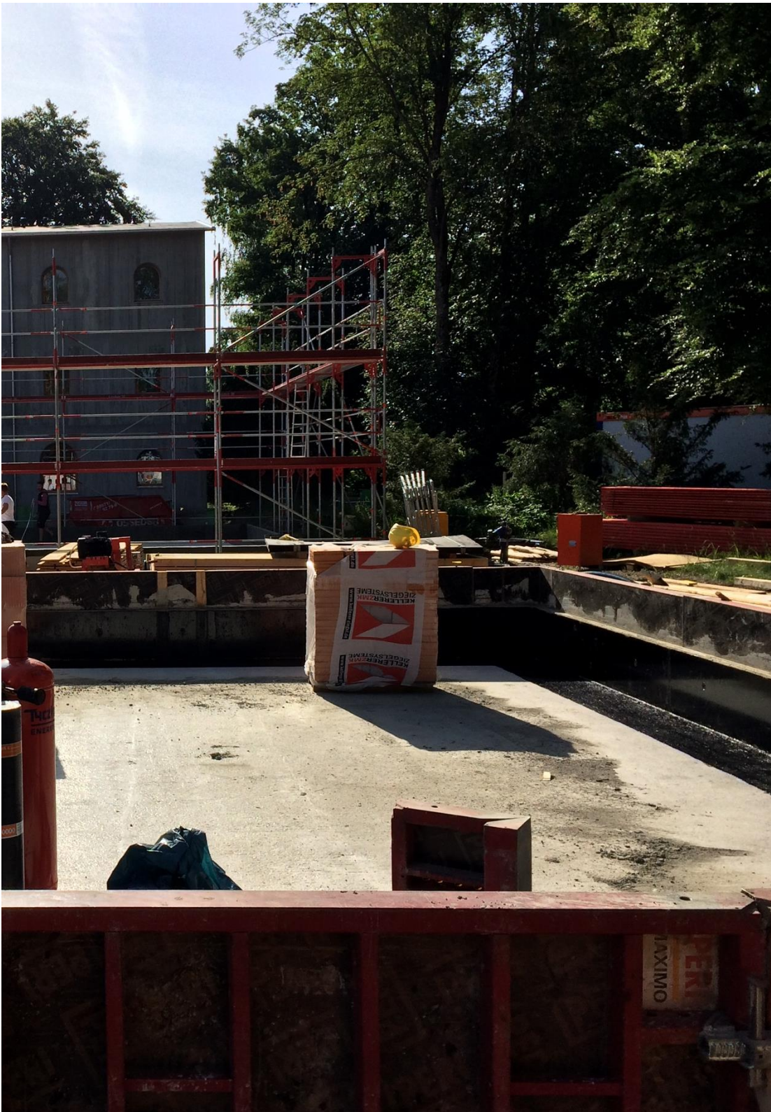
Abbildung 51: Parallel zum Holzbau beginnen die Arbeiten am Mauerwerkshaus.
