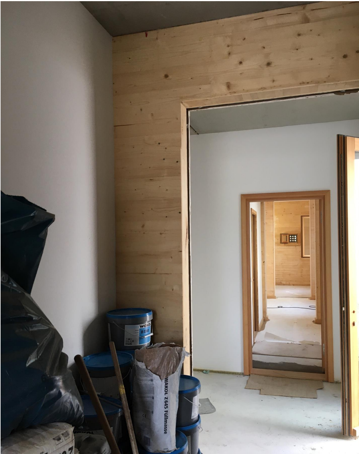
Abbildung 49: Der Bodenleger arbeitet.
