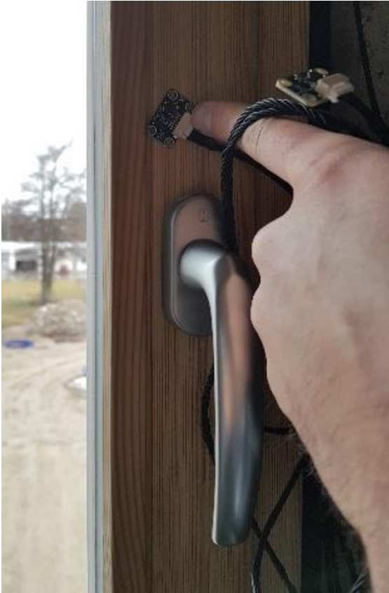
Abbildung 89 Planung der Anbringung der Fensterkontakte am Holzrahmen
