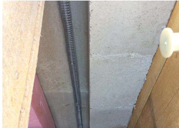
Abbildung 8: Um die Rissbildung durch das Schwinden und Kriechen des Infraleichtbetons gering zu halten, wurde in versetzten Abschnitten betoniert.
