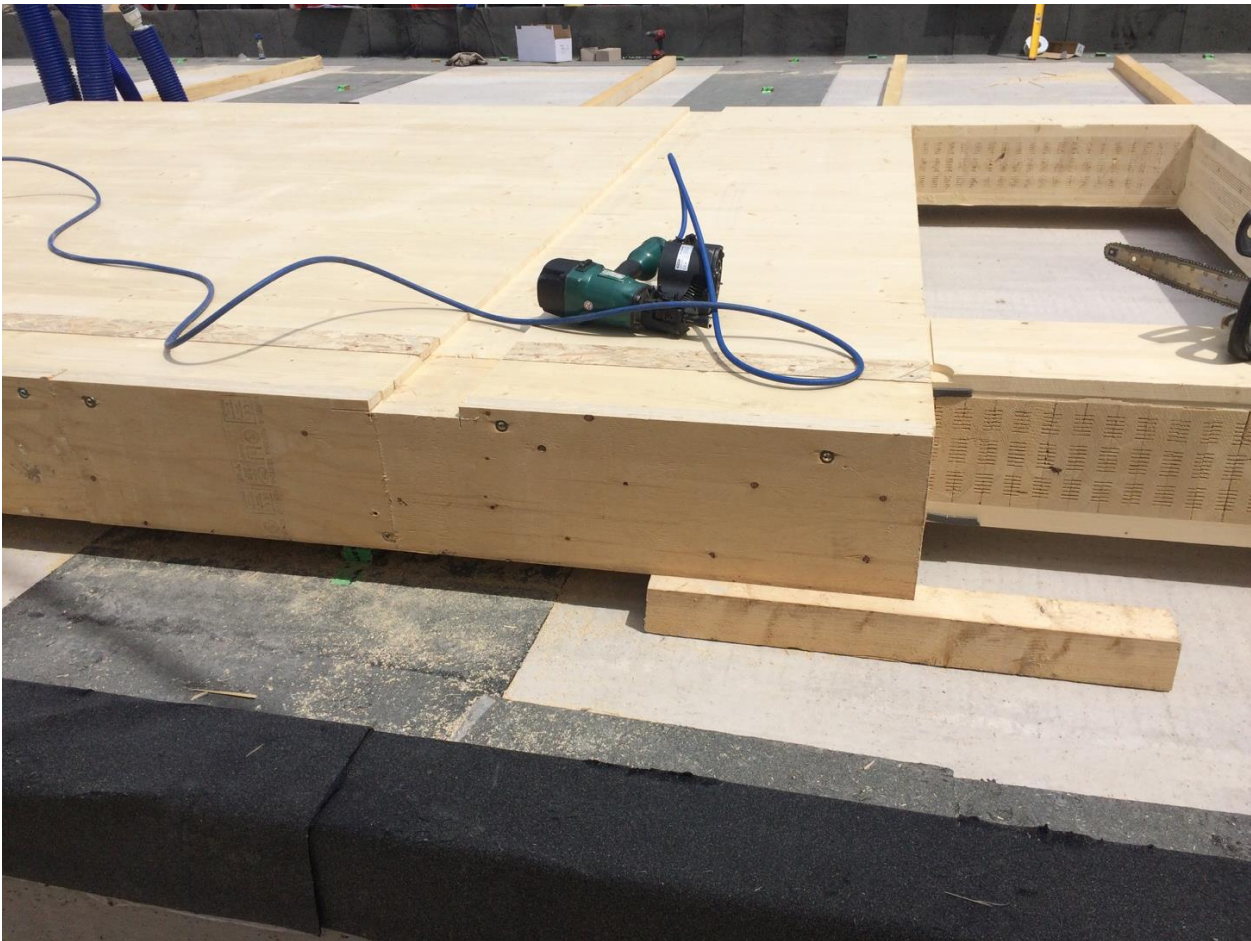
Abbildung 21: Hier wird die Außenwand des Erdgeschosses, welche aufgrund der Höhe einen horizontalen Stoß hat, zu einem Stück montiert.
