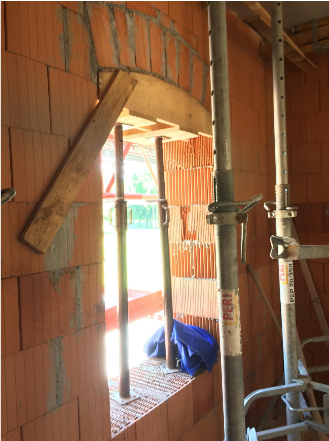
Abbildung 57: Der Sturz über den Fenstern wurde aus dem gleichen Stein wie die Außenwand als Segmentboden hergestellt.
