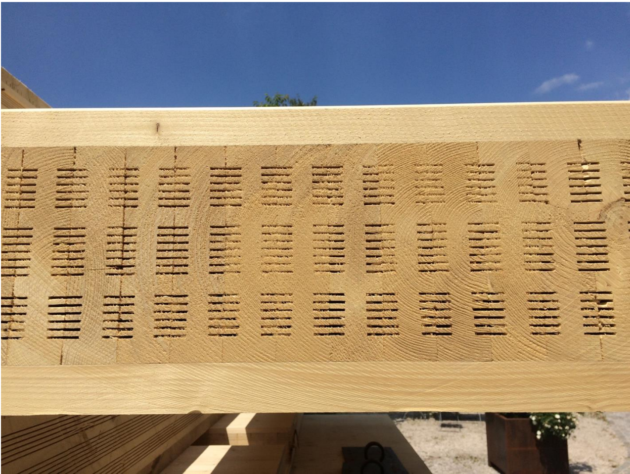
Abbildung 20: Schnittansicht der Außenwand des Holzhauses.
