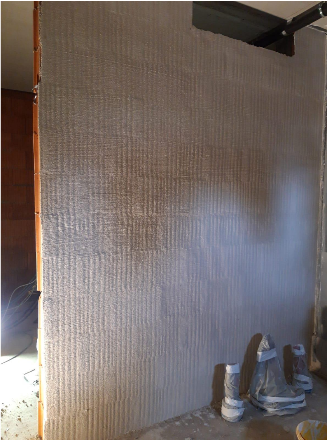
Abbildung 61: Die Kalkschlämme auf der Innenwand wird getestet.
