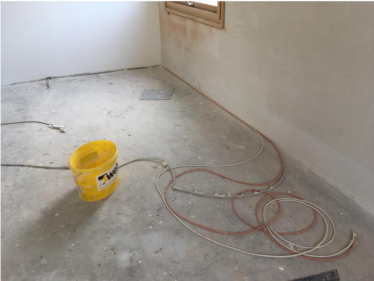
Abbildung 63: Die Elektroinstallation wird verlegt.
