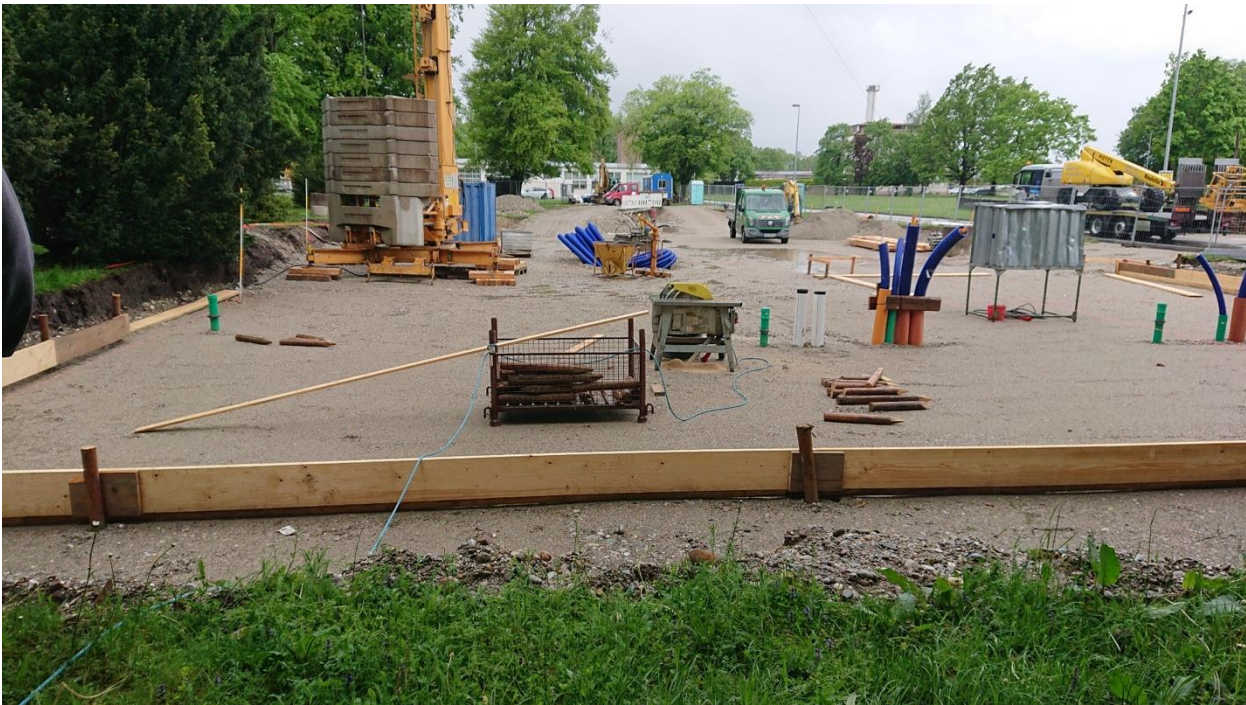
Abbildung 1: Das Planum für die Bodenplatte ist erstellt.
