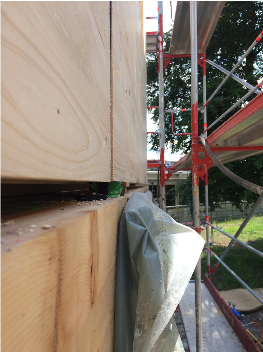
Abbildung 27: Durch den Druck des Betons und vermutlich auch die Flügelglättung hat sich die Wandkrone des Erdgeschosses nach Außen bewegt.
