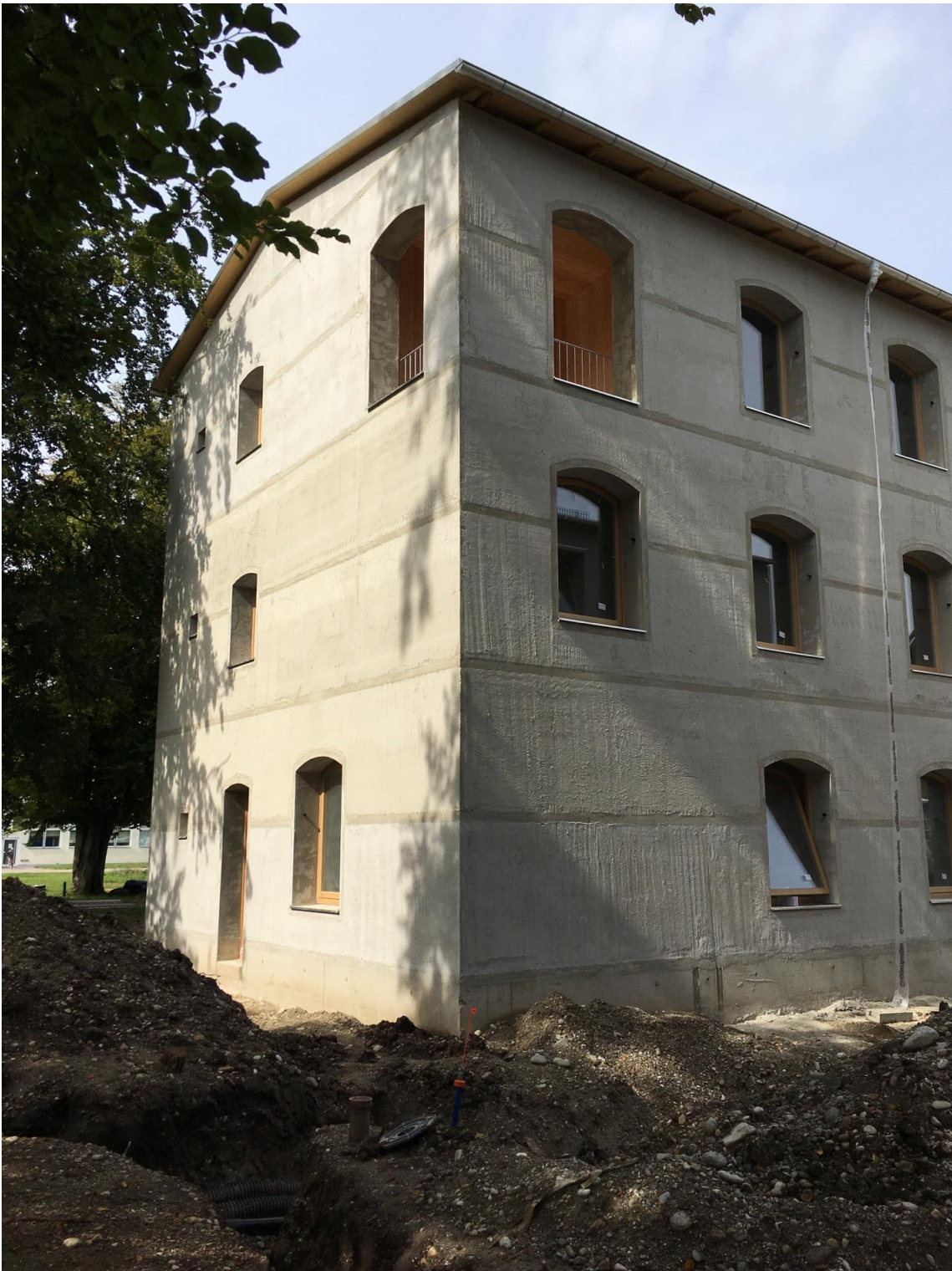
Abbildung 68: Das Mauerwerkshaus von Südosten gesehen.
