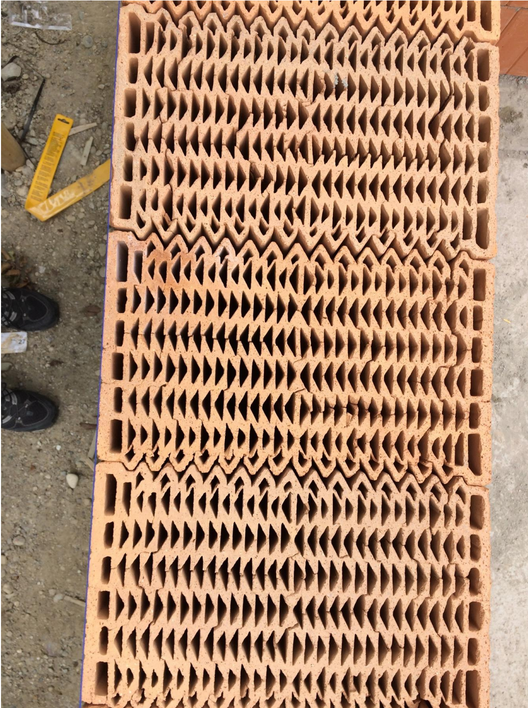
Abbildung 53: Die Luftkammerziegel werden ohne vertikale Mörtelfuge gesetzt.
