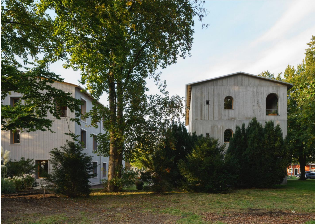
Abbildung 135: Die fertiggestellten Forschungshäuser
