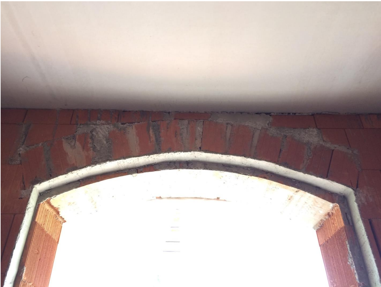
Abbildung 62: Der Anschlag für die Fenster ist hergestellt.
