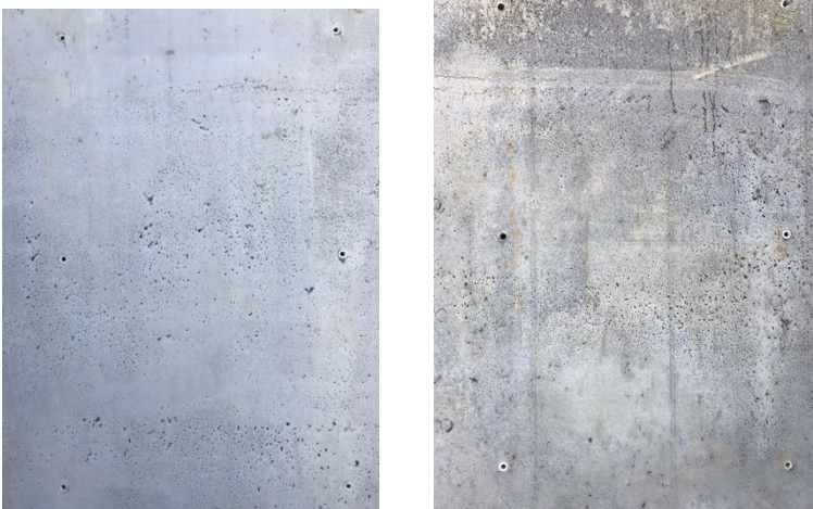
Abbildung 85 Ausschnitt der Außenwand des ersten Obergeschosses des Infraleichtbetonhauses verdichtet mit Innenrüttler (links) und Außenrüttler (rechts)
