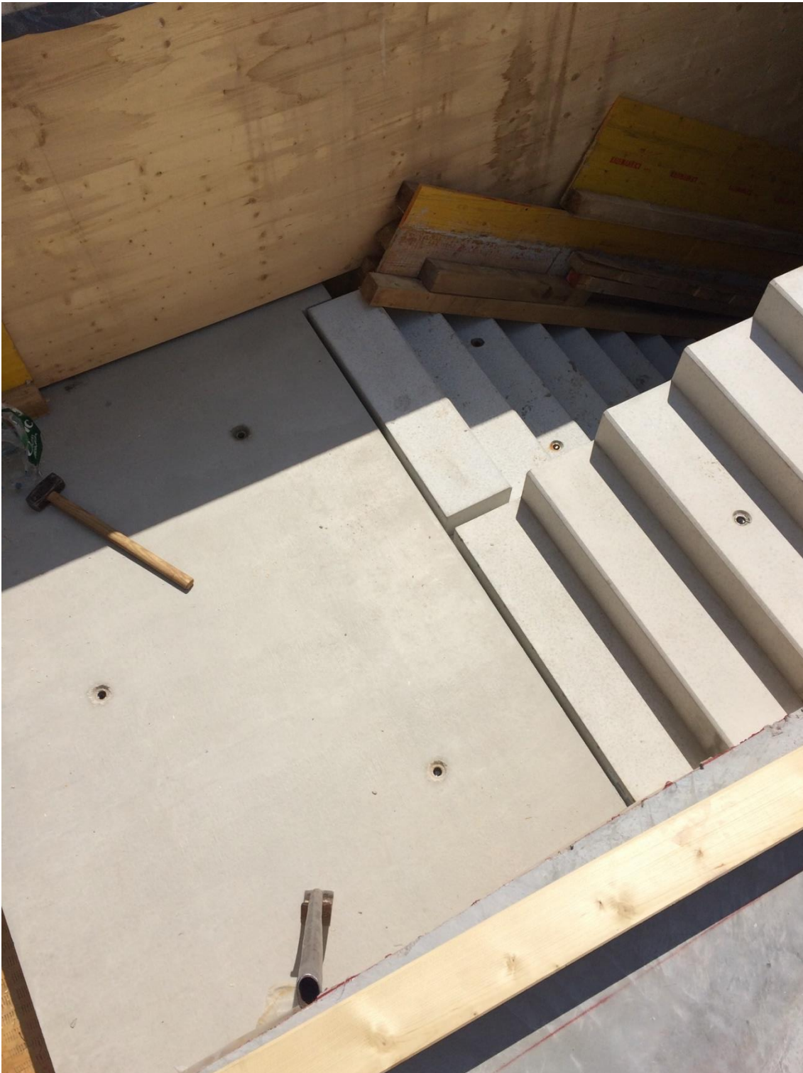
Abbildung 28: Zwischenpodest und Treppenläufe wurden vorgefertigt und durch den Rohbauer mit dem Kran eingehoben.
