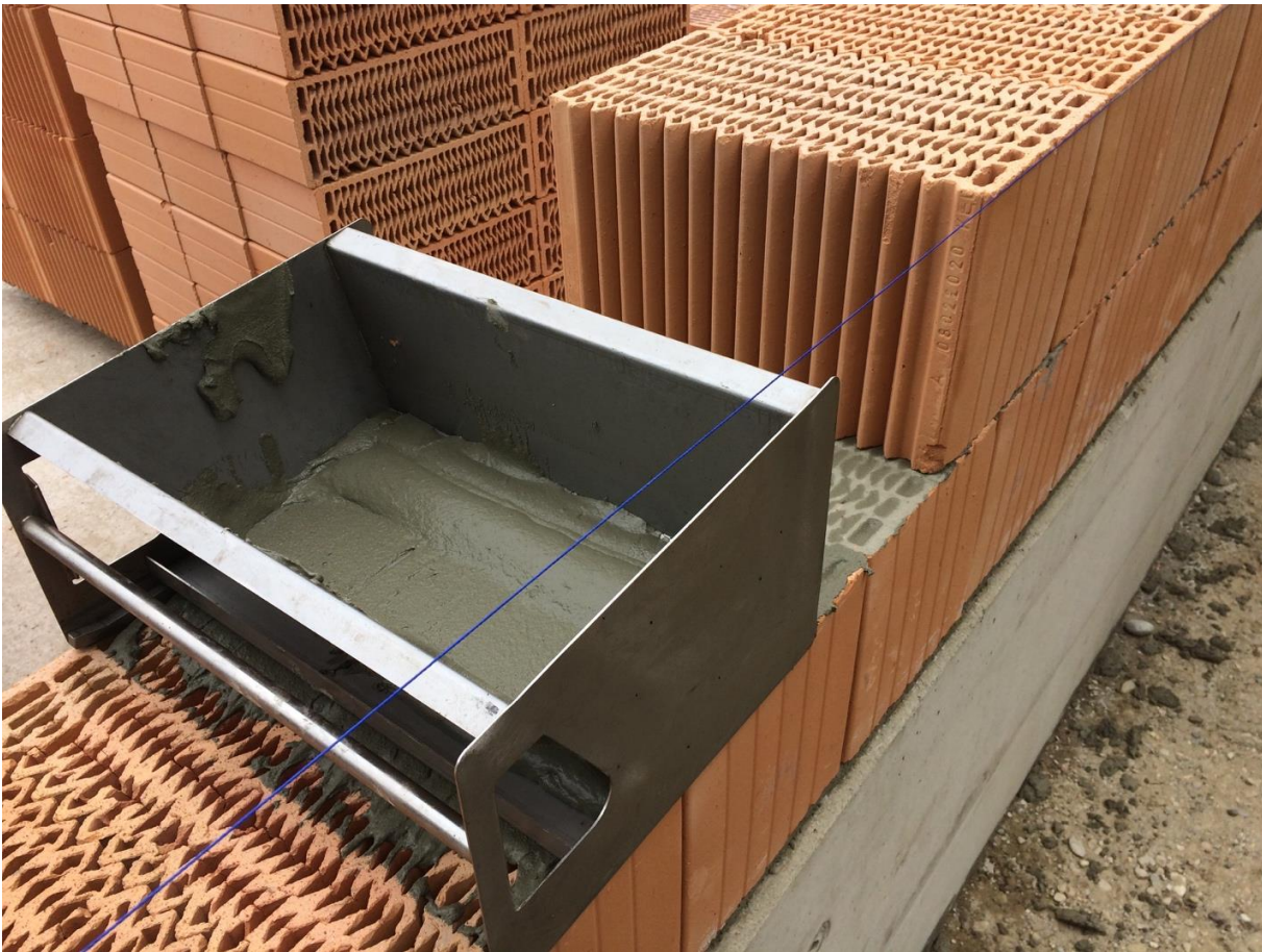
Abbildung 55: Dafür wird ein spezieller Mörtelschlitten verwendet.
