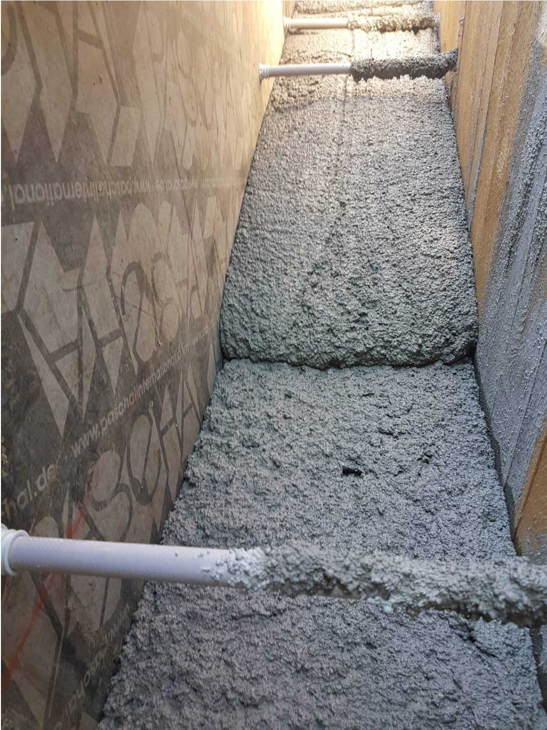
Abbildung 4: Blick von oben in die geschalte Außenwand.
