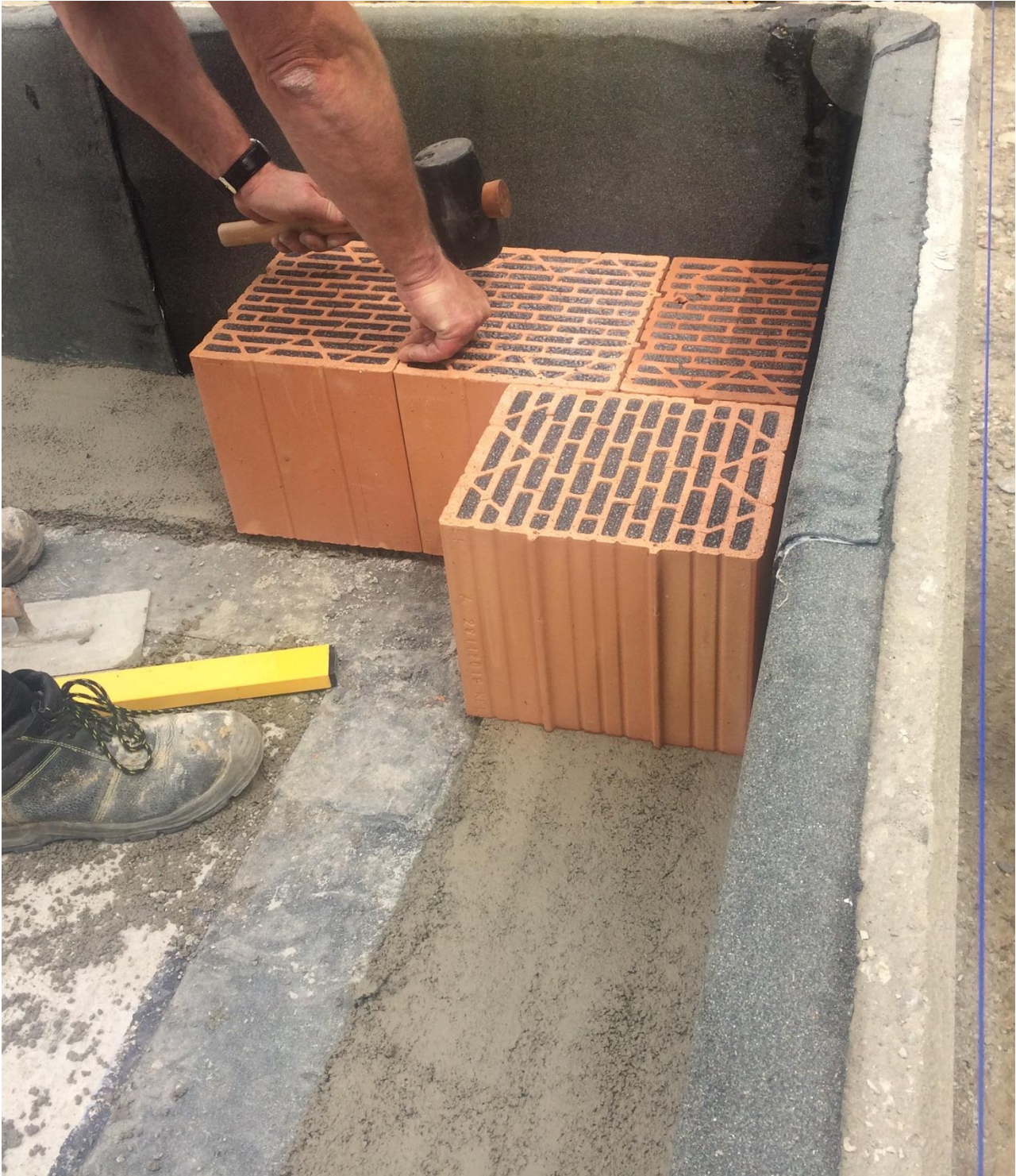
Abbildung 52: Der Kimmstein wird gesetzt.
