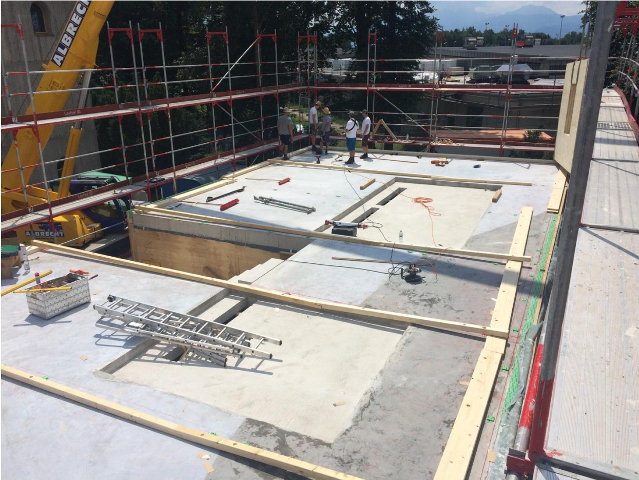
Abbildung 26: Eine Woche später: Die Decke über dem Erdgeschoss wird betoniert.
