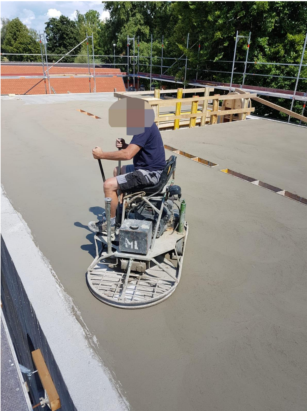
Abbildung 11: Da die Decke ohne weiteren Fußbodenaufbau direkt mit einem Bodenbelag belegt wird, kommt ein Flügelglätter zum Einsatz.
