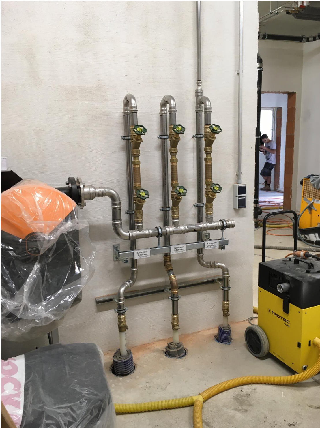
Abbildung 67: Verteilung des Frischwassers in die drei Gebäude.
