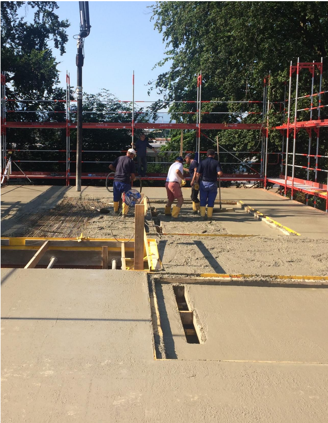
Abbildung 56: Betonage der Decke.
