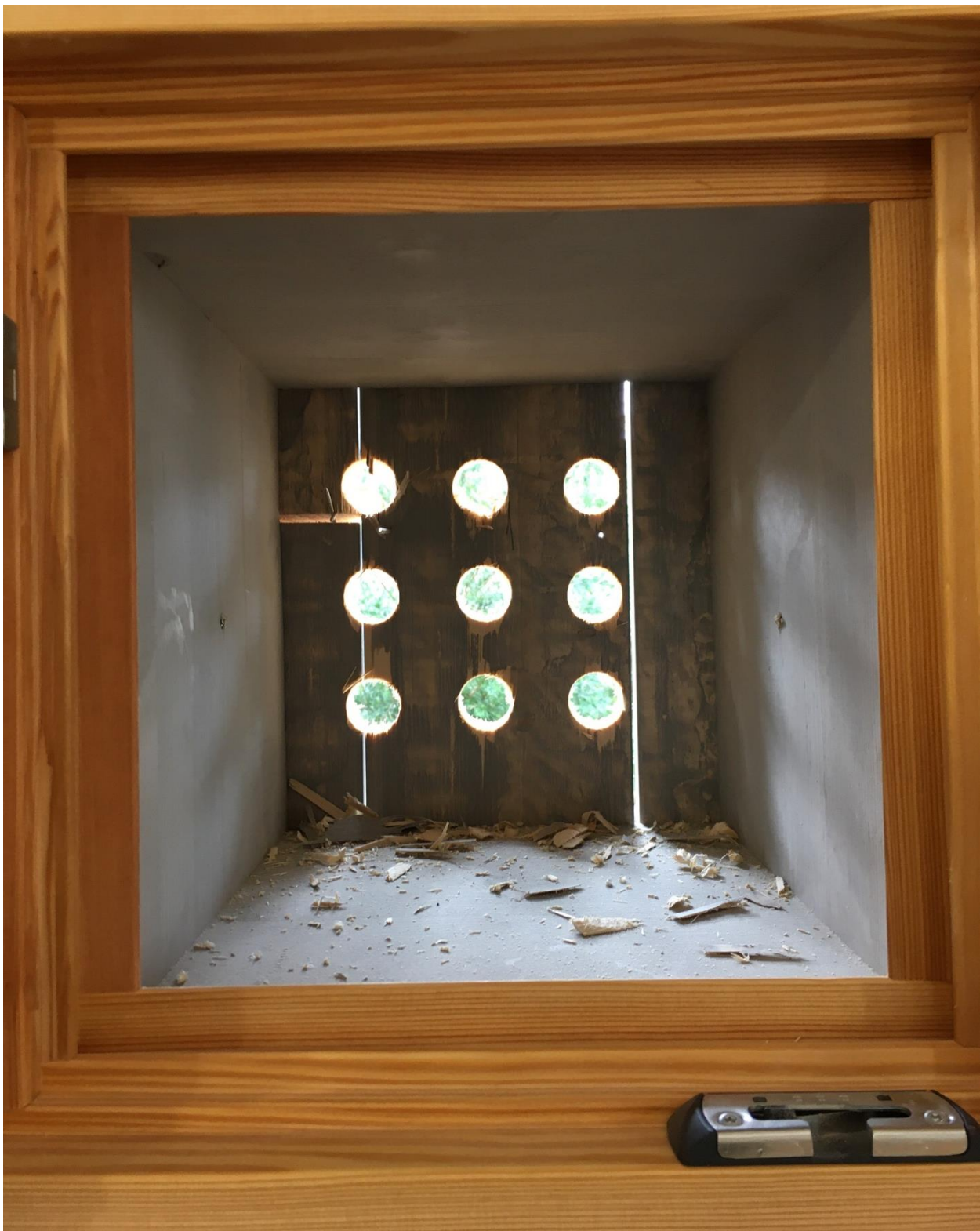
Abbildung 48: Eine der Lüftungsöffnungen der Speisekammern.
