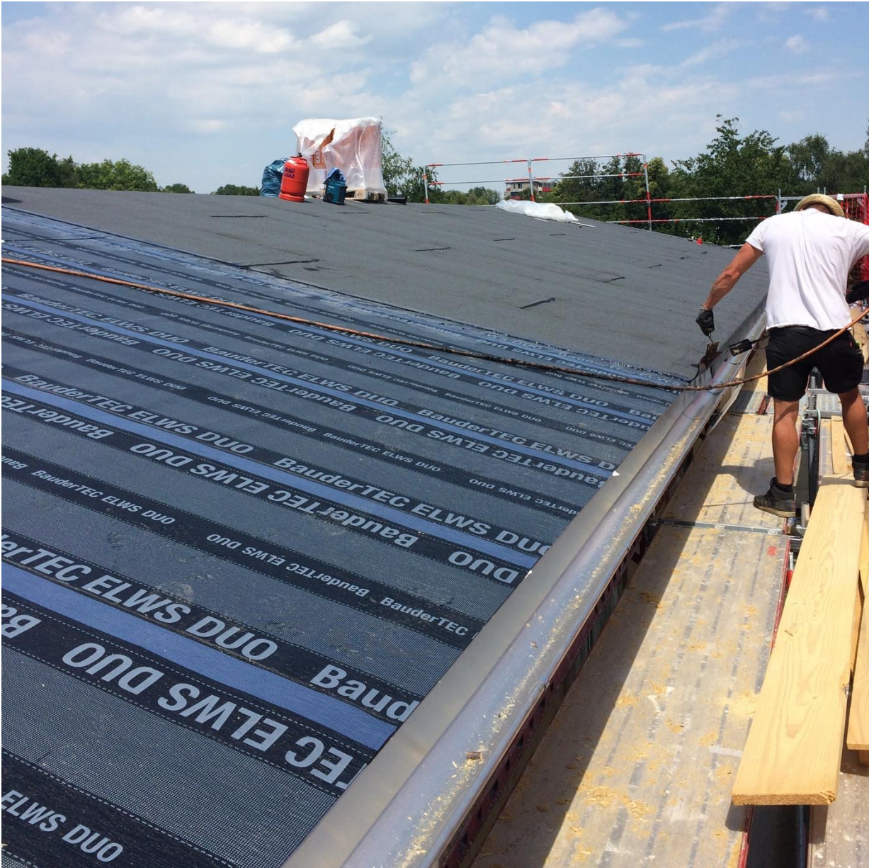
Abbildung 45: Das Dach wird eingedichtet.
