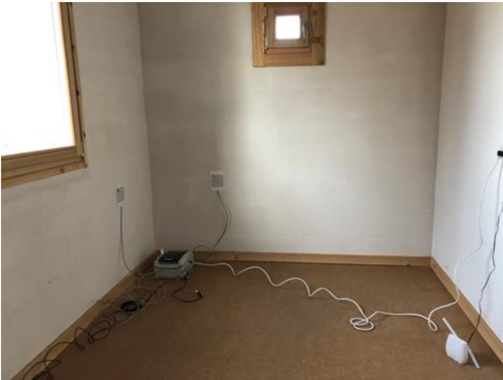
Abbildung 73: Aufbau Wärmestrommessung Mauerwerksgebäude, 2. Obergeschoss
