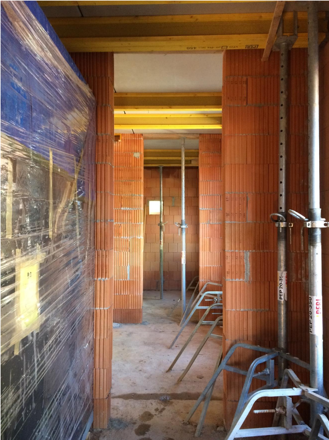
Abbildung 59: Hier ein Blick ins Gebäude, links die bekannte Badfertigzelle.
