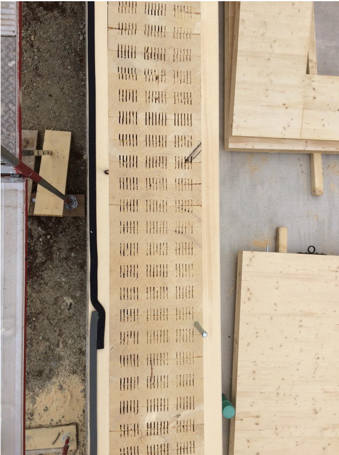
Abbildung 23: Die Außenwände stehen.
