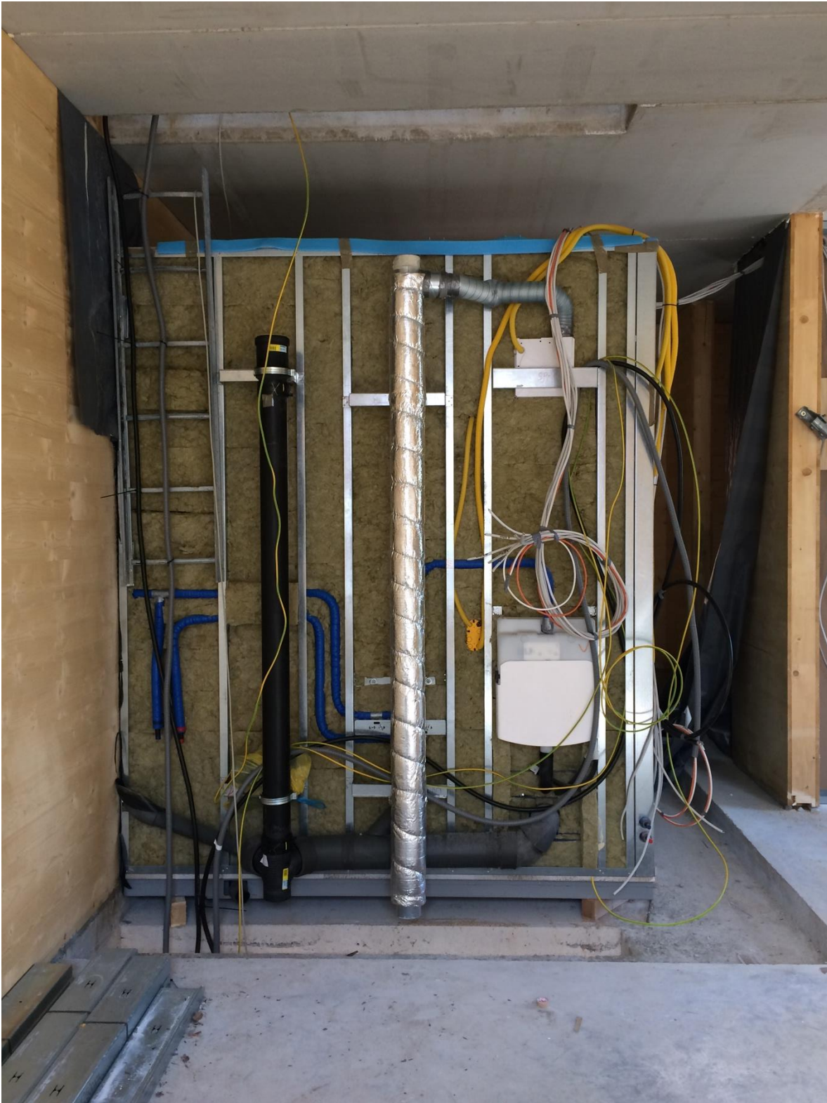
Abbildung 42: Badzelle ohne Folien.
