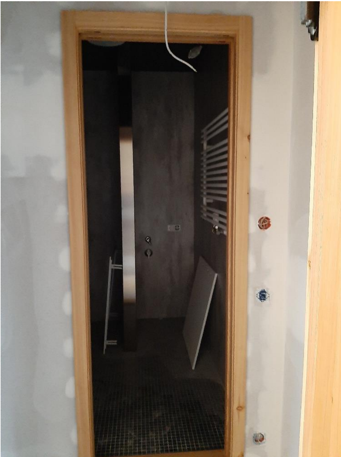
Abbildung 17: Ein Blick in eine der fertig angelieferten Badzellen.
