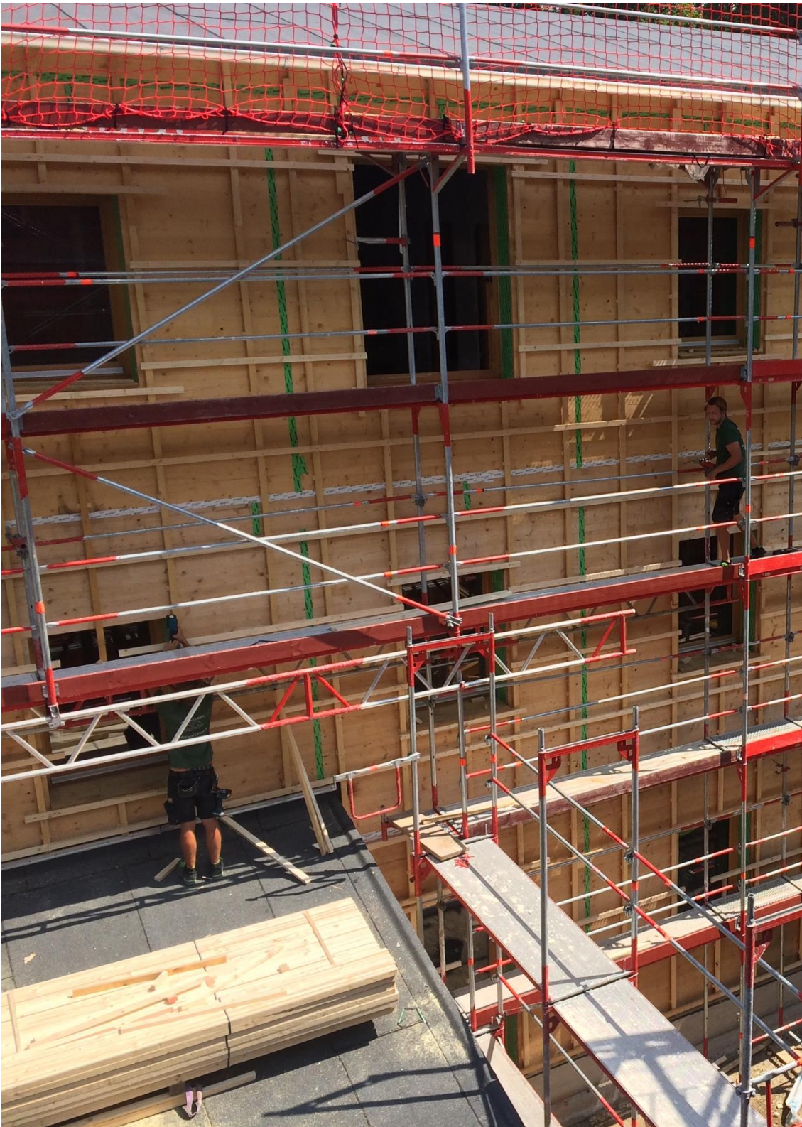
Abbildung 46: Die Unterkonstruktion der Holzverschalung wird verbaut.
