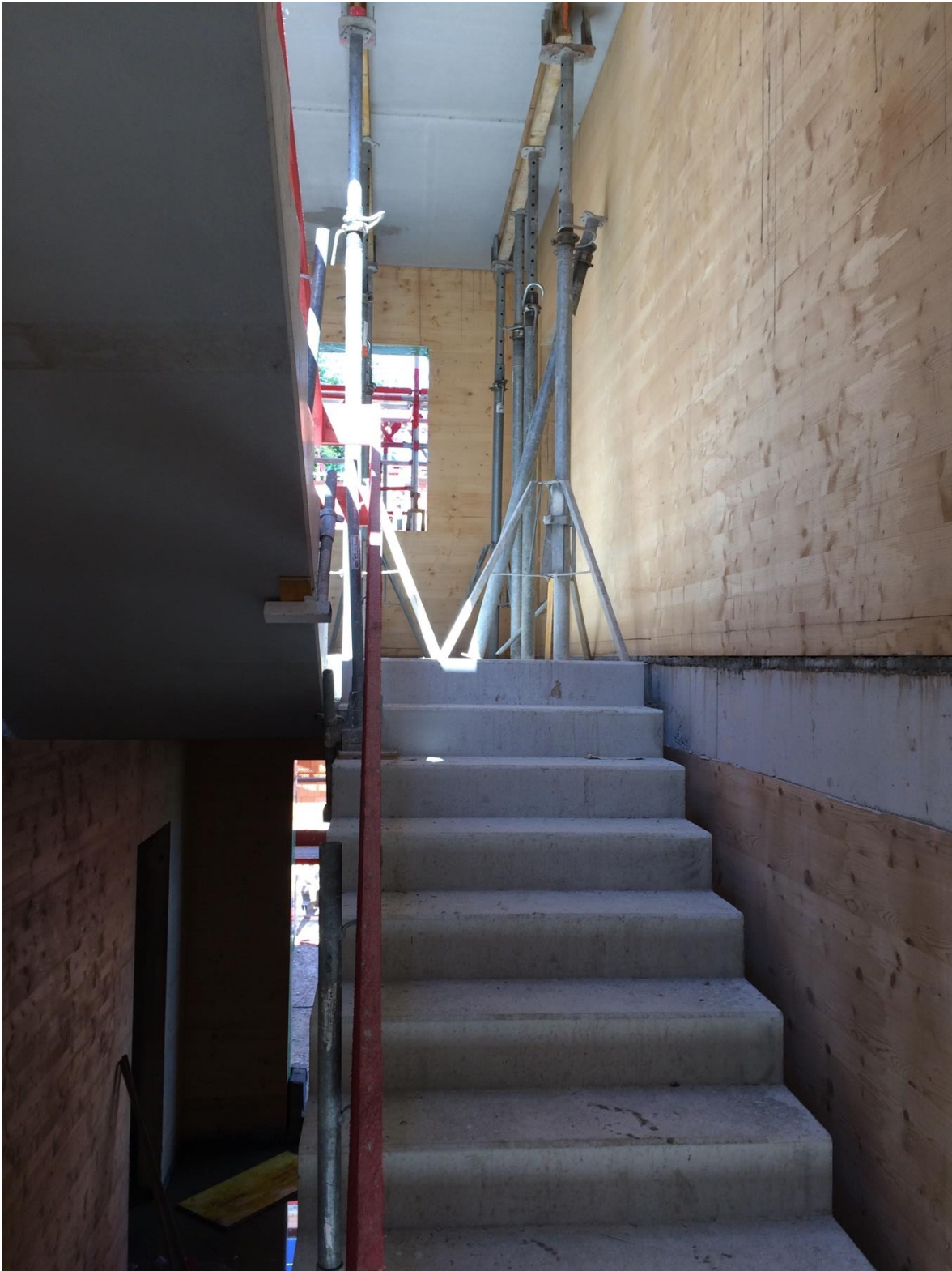
Abbildung 32: Blick ins Treppenhaus.
