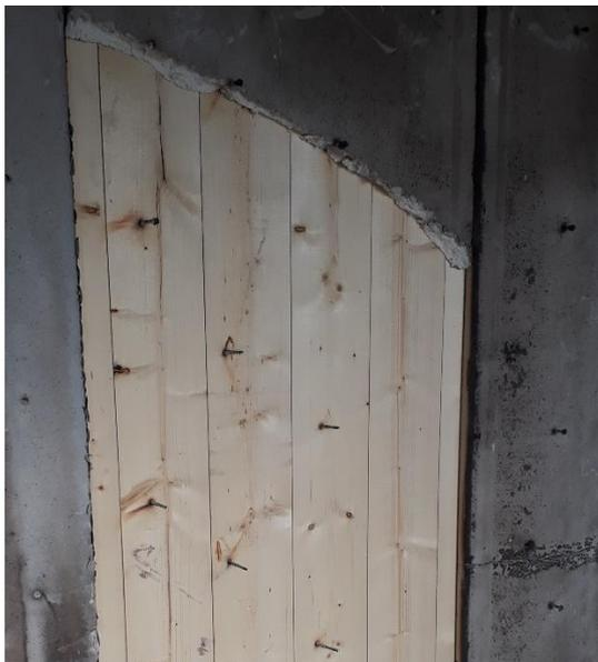
*Bild 3 Verbindungsmittel nach Entfernen der Brandschutzbekleidung, V0*
