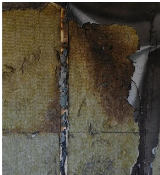
*Bild 4 Verfärbungen an den Befestigungspunkten am Ständer einer Holztafelbauwand, V4*
