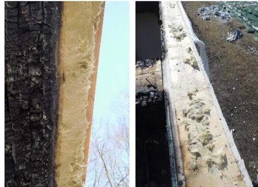
Bild 10 V4 - Bauteilanschluss – Decke an Wand 3
