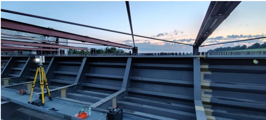
Abbildung 1-1: Messung an der Talbrücke Thulba, September 2021
