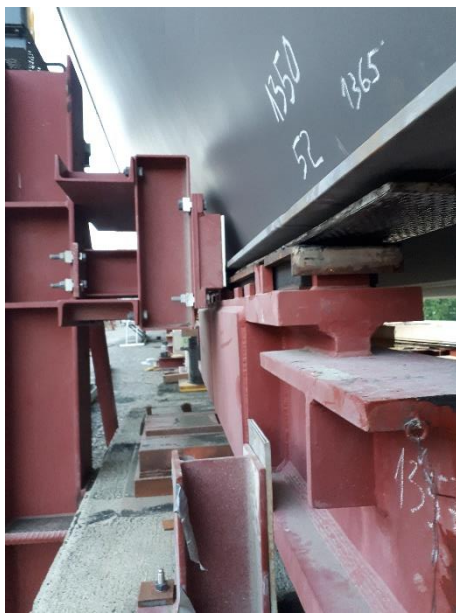
Abbildung 3-3: Verschublager mit Seitenführung; Talbrücke Thulba (links), Gottleubatalbrücke (rechts) (2021)
