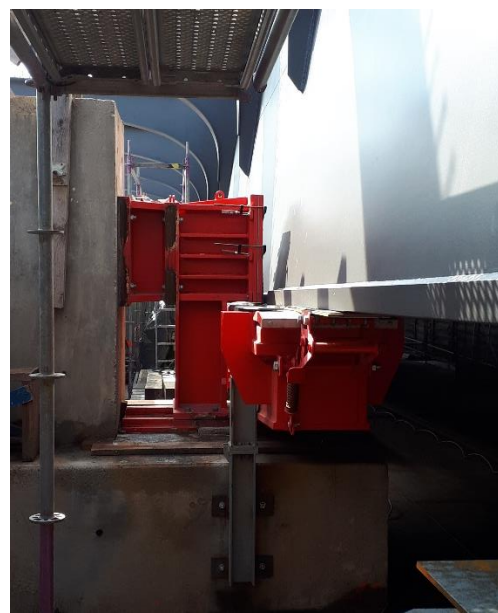
Abbildung 3-3: Verschublager mit Seitenführung; Talbrücke Thulba (links), Gottleubatalbrücke (rechts) (2021)
