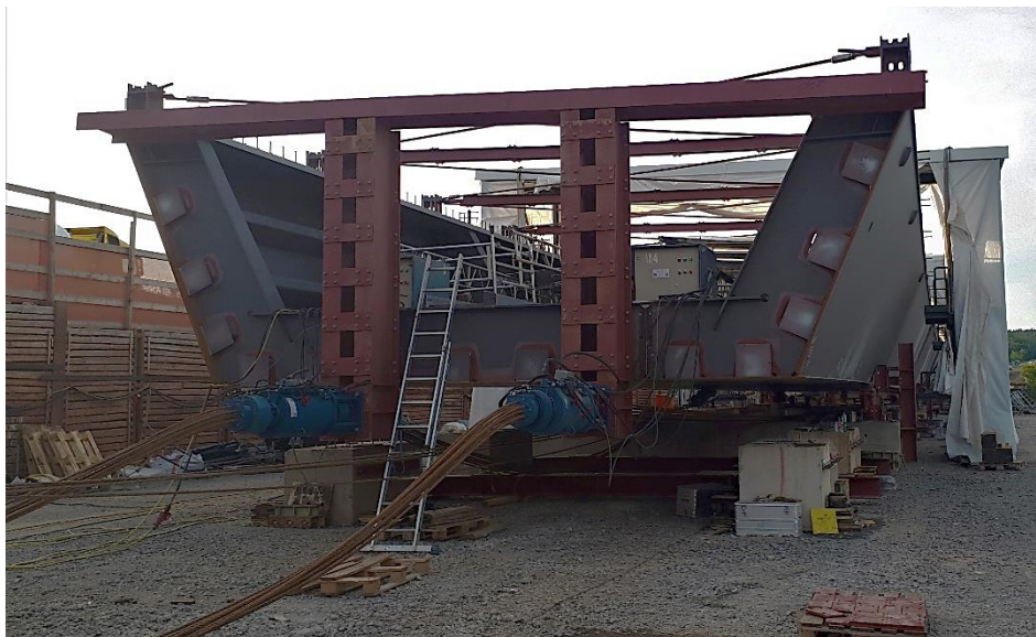
Abbildung 3-1: Schematische Darstellung eines Einschubs (Talbrücke Thulba 2021)
