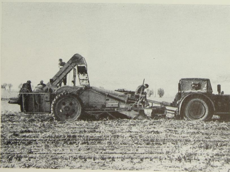
Bild 18: Gesamtansicht der Maschine C
