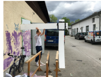
Testen der Durchbiegung der Platten
