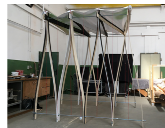
Pavillon mit fertiger Dachhaut
