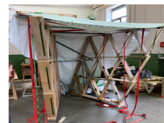
Rohbau mit Plane
