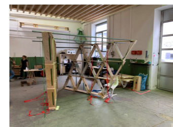
Rohbau mit Druckstäben
