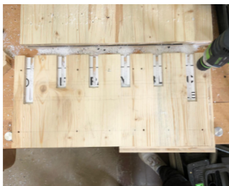
Bohren der Nietlöcher
