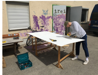
Zuschneiden der Platten
