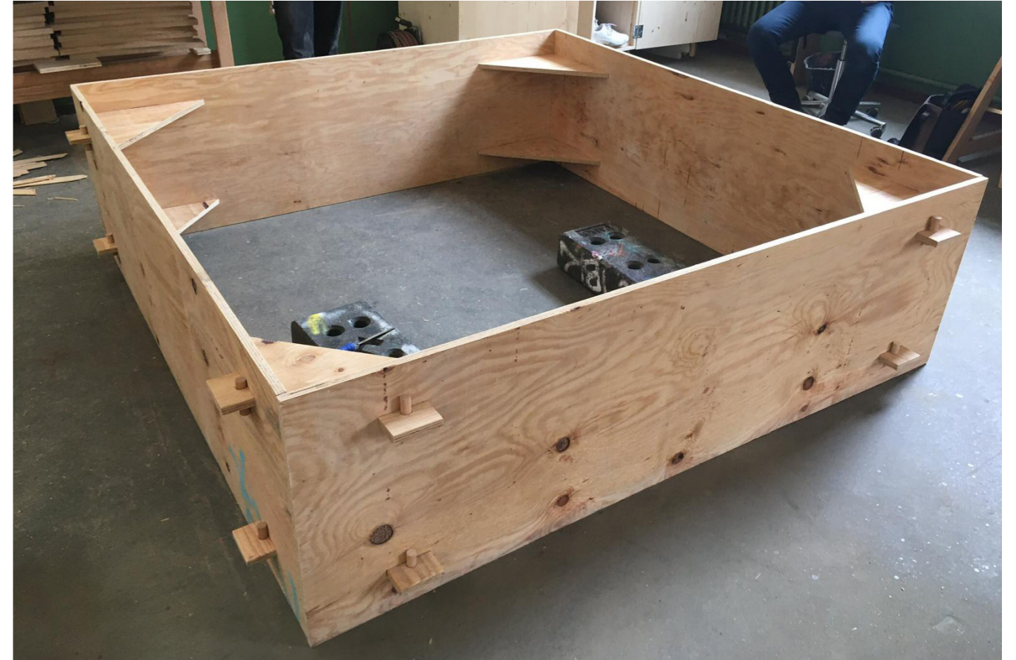
Aufbau des Moduls am Boden
