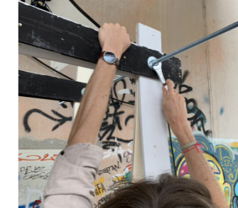
Festziehen der Muttern nach dem Aufrichten
