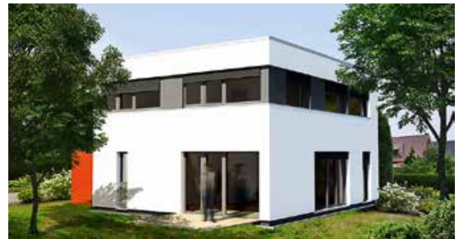
Die Photovoltaik-Anlage des intelligenten Wohnhauses in Hallbergmoos erzeugt Strom für elektrische Geräte; der Überschuss dient zum Heizen.
