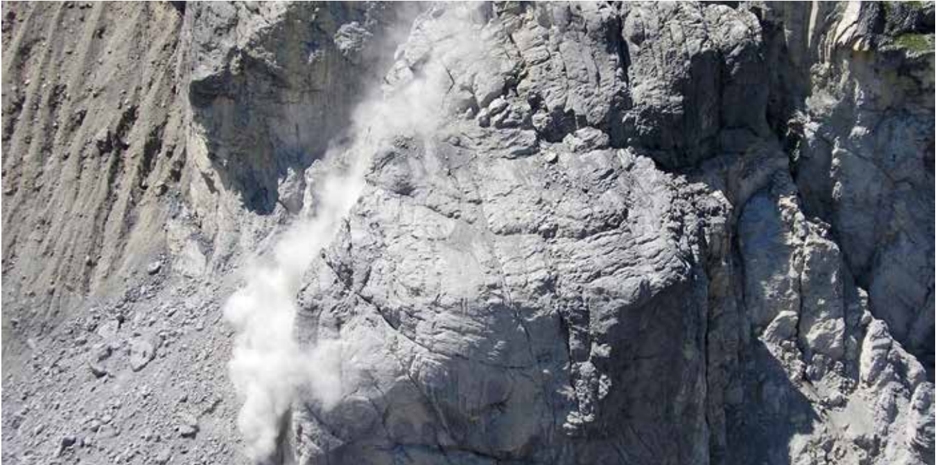
Vorbereitung eines großen Felssturzes an der Eiger-Ostflanke, 2006
