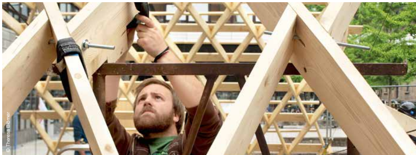
Architektur-Student Mattia Zucco bei der Arbeit am Zollinger-Lamellendach vor dem Nordgebäude der TUM.
