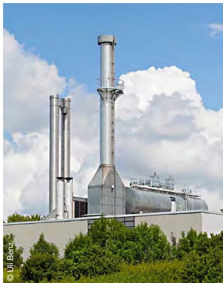
Südansicht des Heizkraftwerks der TUM am Campus Garching
