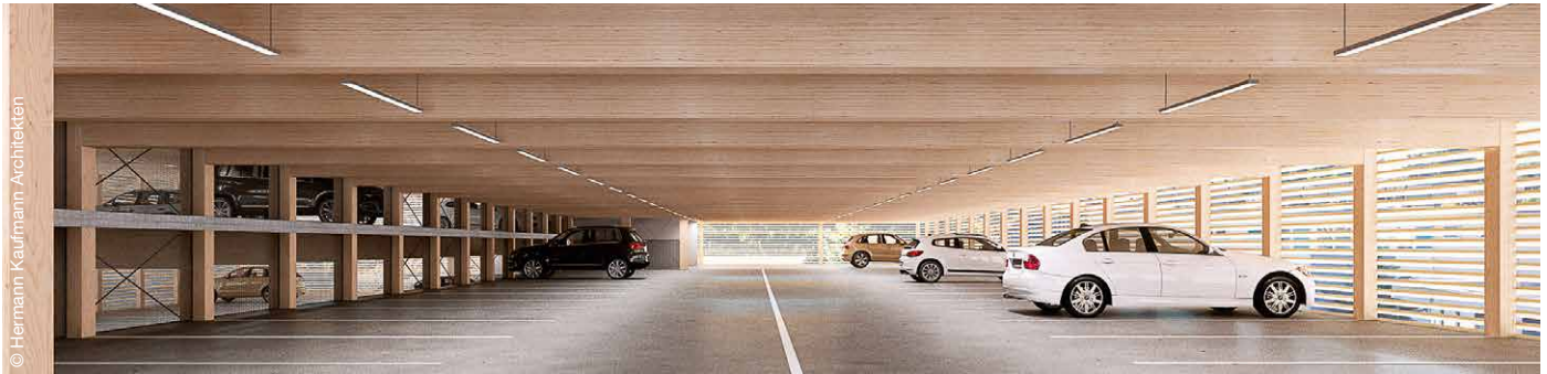
Moderne Holzforschung macht's möglich: Buchenholz lässt sich heute auch für tragende Gebäudeteile nutzen. So könnte etwa eine Garage aus Buche aussehen.
