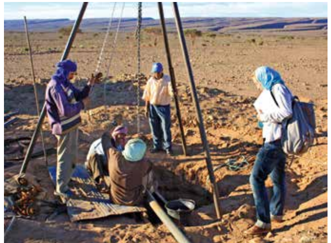
Am Brunnen einer Familie wird das Filterrohr ausgetauscht.
