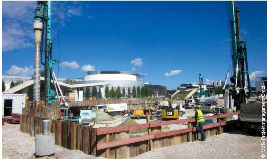
Wo sich derzeit noch die Baufahrzeuge tummeln, wird bald das lebendige Zentrum des Campus Garching sein.
