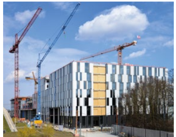
Im südlichen Teil des »GALILEO« ist schon die zukünftige Fassadengestaltung zu erkennen. © Andreas Battenberg
