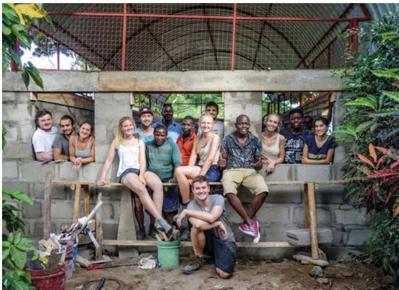
Der Rohbau steht: Arbeiter und Studierende lernten von- und miteinander. © Svenja Wolff
