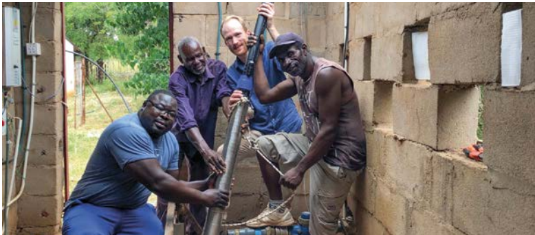
Gemeinsam mit den lokalen Technikern installiert TUM-Volontär Julius Hildebrand die Wasserpumpe.
