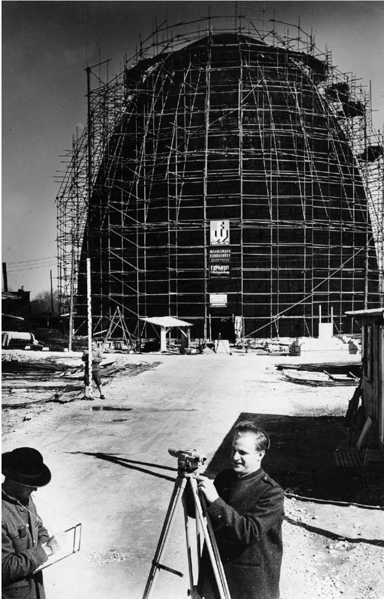
Eingerüstete Reaktorkuppel des FRM, Anfang 1957
