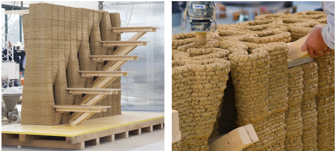
Abbildung 2.18: 3D-Gedruckte Wand mit integrierter Treppe. (PA, 2019a)
