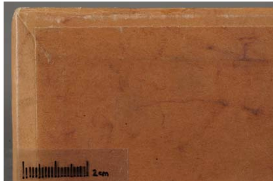
13: Schubert 2, Elefantpapier, rechte Außenwand, obere hintere Ecke.
