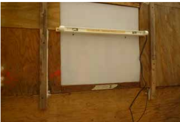
Abb. 160 Anbringen der Fassungen 2014
