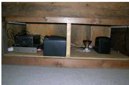
Abb. 337 Technikfach nach dem Aufbau
