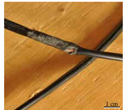
Abb. 150 Isolierungsschaden, Kabel der Leuchtstofflampe II
