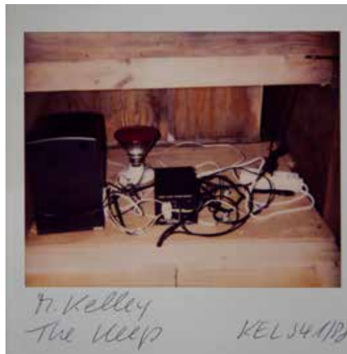
Abb. 327 Rechtes Technikfach (v. hi.) 1998
