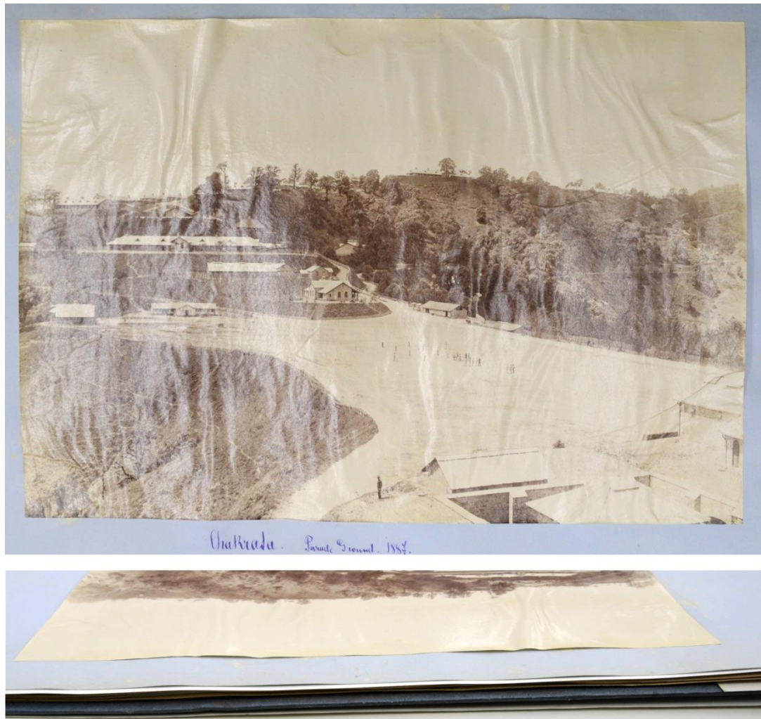
Abb. 68 Albuminfotografie 10/1 im Streiflicht: Starke Wellung des Bildes + Ablösung von der Albumseite Quelle: Nadine Bretz / IBR
