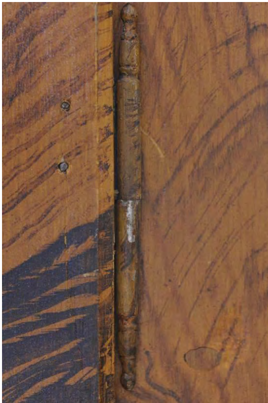
Abb. 158: Übermalter Beschlag am rechten Türblatt (Inv. Nr. 1990/00567/0))
