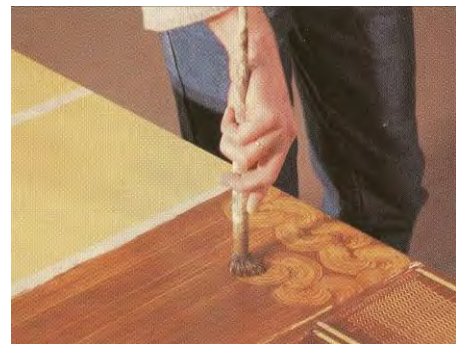
Abb. 76: Strukturierung der Oberfläche durch Drehen eines Pinsels (APEL 1991, S. 98)
